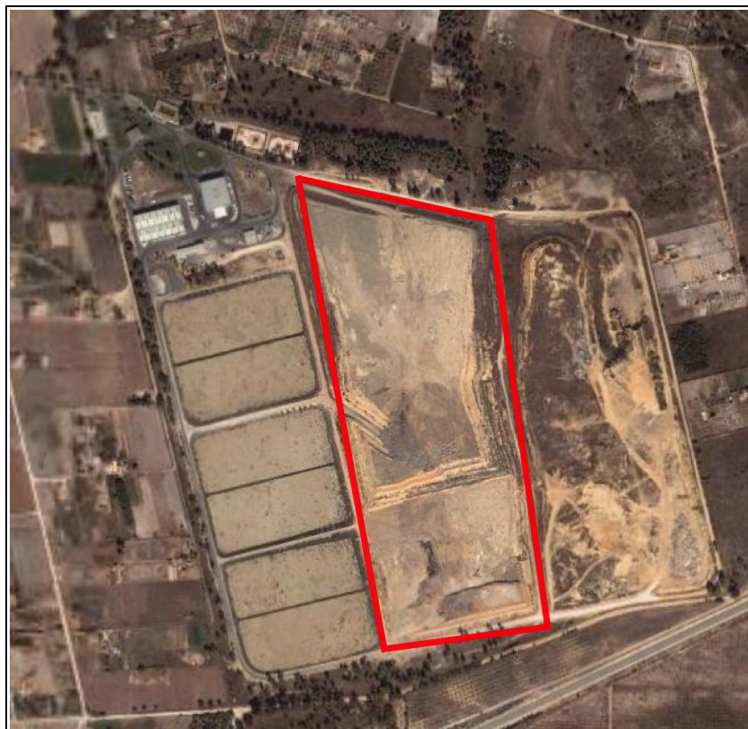
Figura 2.15 - Zona de Intervenção no Aterro da Amarsul em Palmela (Cabeças e Dores, 2008)
