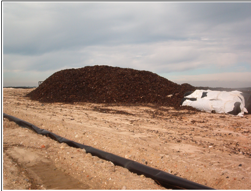
Figura 2.16 - Chips de pneus a aplicar na zona de intervenção do Aterro da Amarsul
