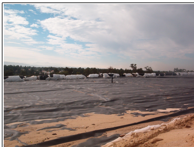
Figura 2.21 - Zona de intervenção onde foi efectuada a aplicação de chips de pneus
