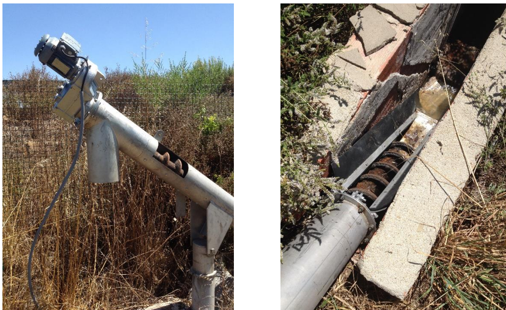
Figura 5.1 – Tamisador da área de serviço de Almodôvar, sentido Norte/Sul.
