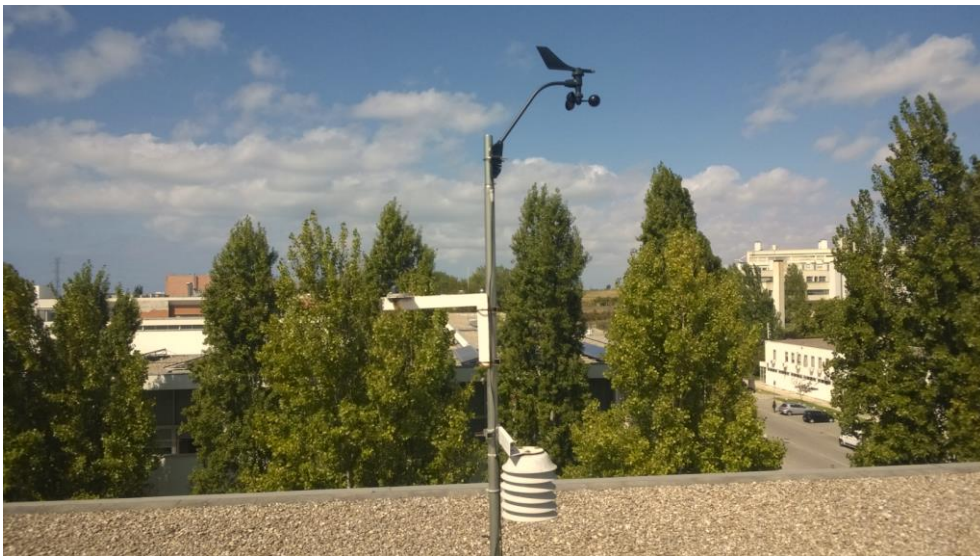
Figura 3.2 - Estação meteorológica instalada no topo do edifício do DEE
