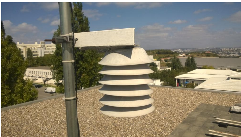
Figura 3.4 - Termómetro ECT Temperature instalado no topo do edifício do DEE
