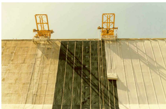
Figura 20 - Aplicação de tela impermeabilizante no paramento de montante da barragem de Pracana durante as obras de reabilitação desta (adaptado de Batista & Piteira Gomes, (2012)).
