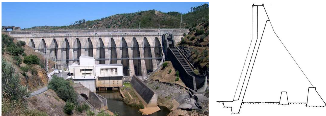
Figura 4 - Barragem de Pracana (vista de jusante, à esquerda, e perfil de um dos contrafortes, à direita) (www.cnpqb.apambiente.pt 2016d, 2016h).
