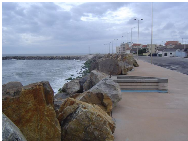
Figura 6. Furadouro. Defesas costeiras na parte sul. O enrocamento existente teve de ser reforçado para proteger a povoação das investidas no mar no inverno de 2014 (Fotografia de Joana Freitas).
