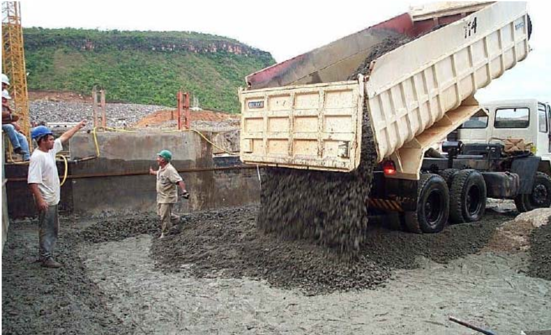
Figura 3.9 – Transporte da mistura de BCC através de caminhões (Portland Cement Association, 2003).
