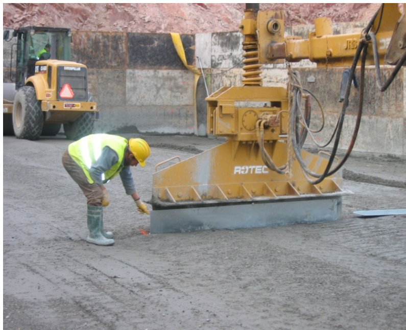
Figura 3.23 – Materialização de uma junta de contração na barragem do Pedrógão (Castro, et al, 2006).
