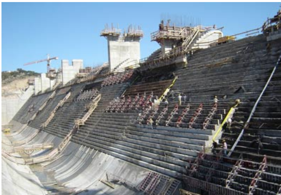
Figura 3.24 – Construção do paramento jusante na barragem de Pedrógão (Peri, 2006).
