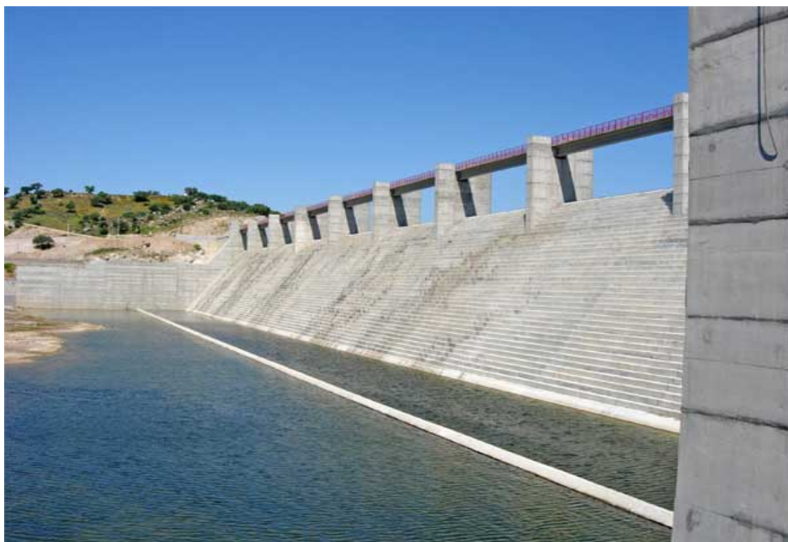
Figura 1.13 - Aspecto da barragem do Pedrógão em funcionamento (PERI, 2006)
