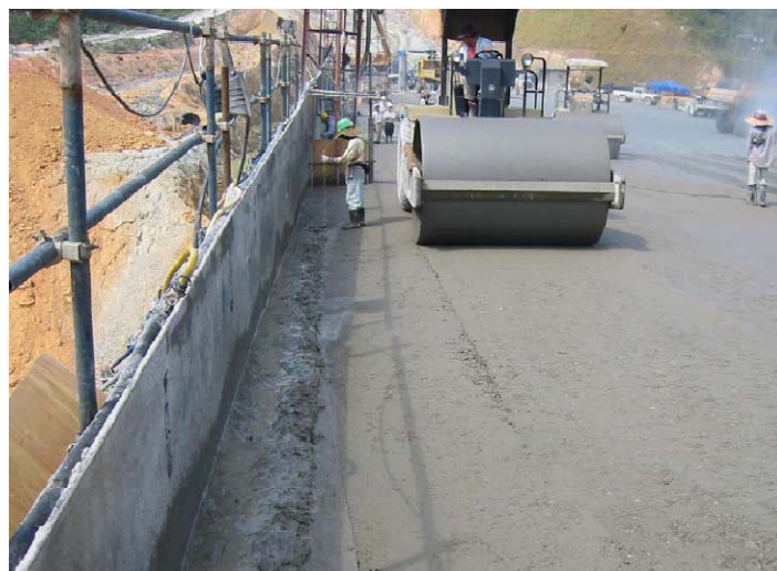
Figura 3.18 – Preenchimento com betão convencional junto à cofragem (Brian, 2008).
