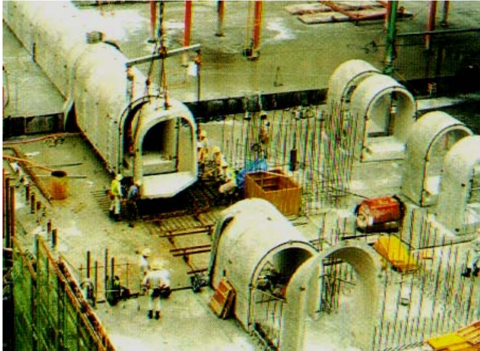
Figura 3.25 – Galeria de visita (USACE, 2000).
