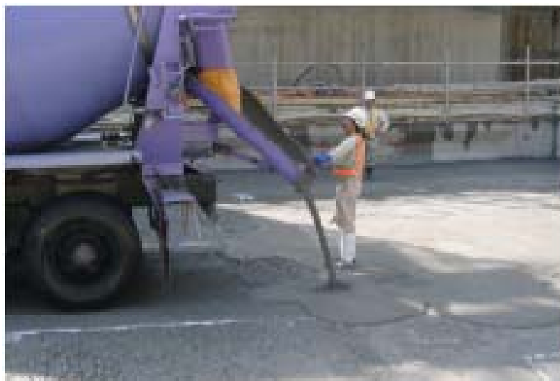
Figura 3.22 – Colocação da mistura de ligação em obra (Nagayama, 2008).
