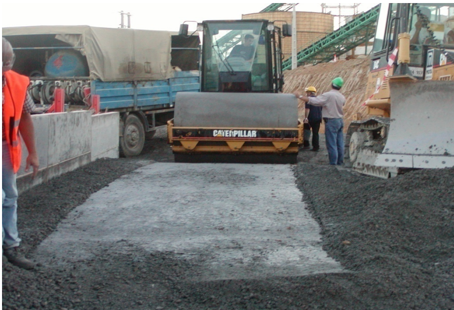
Figura 3.15 - Compactação de uma camada de BCC (Castro, e tal, 2006).
