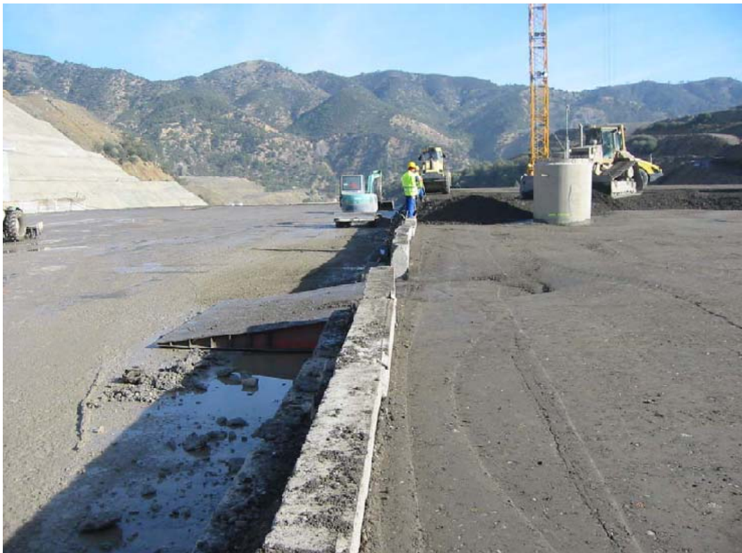
Figura 3.16 – Aspecto do BCC depois de compactado na barragem de Koudiat Acerdoune (Brian, 2008).
