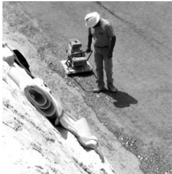
Figura 3.17 – Compactação junto à rocha com equipamento manual (ACI, 1999).
