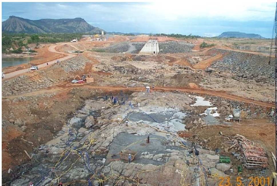
Figura 3.7 – Preparação de fundação para barragem em BCC (Portland Cement Association, 2003).
