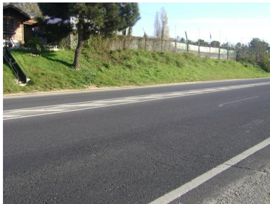
Figura 5.38 – Zona de escavação
