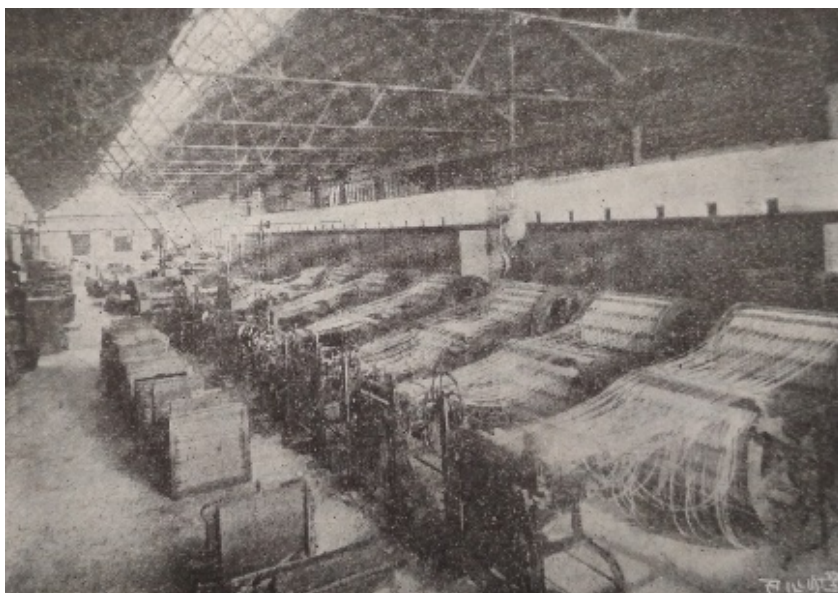
Figura 4. Oficina de fábrica de pavios para os fósforos de cera. Fonte: João Antonio Correia dos Santos, Problemas Resolvidos e Manipulações de Química – III Volume (Lisboa: Typ. da Cooperativa Militar, 1911).
