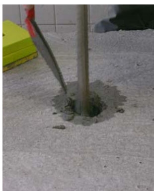
Figura 4.14. Selagem dos varões
