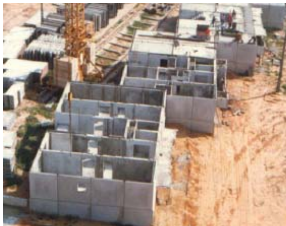
Figura 2.4. Construção com paredes resistentes (gentilmente cedida pelo Prof. Válder Lúcio)
