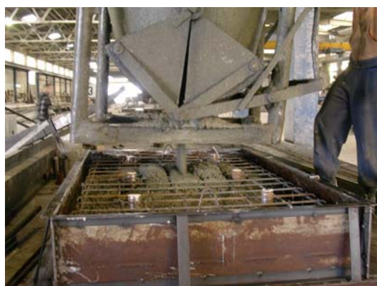
Figura 4.12. Betonagem dos maciços de betão
