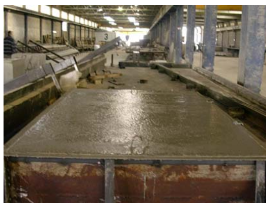
Figura 4.13. Aspecto final da betonagem
