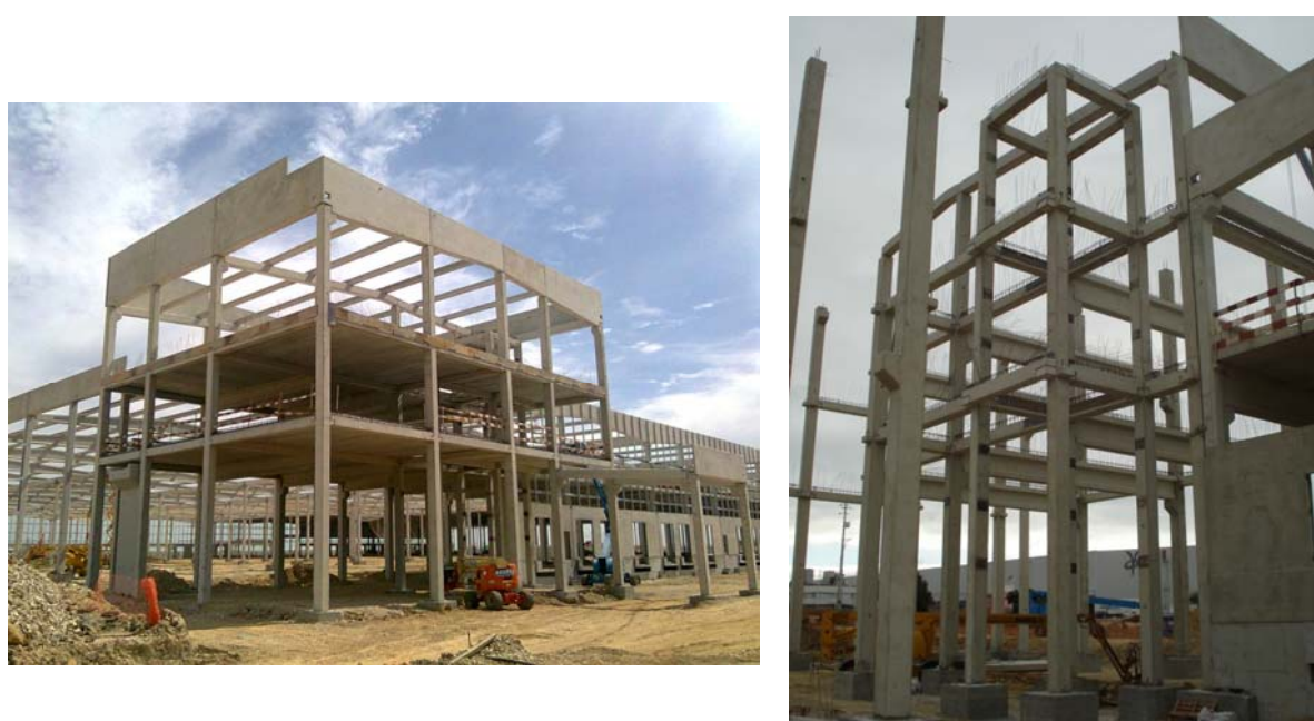
Figura 2.1. Estruturas reticuladas de um edifício de escritórios e armazém, ("Logplace" - Azambuja)
