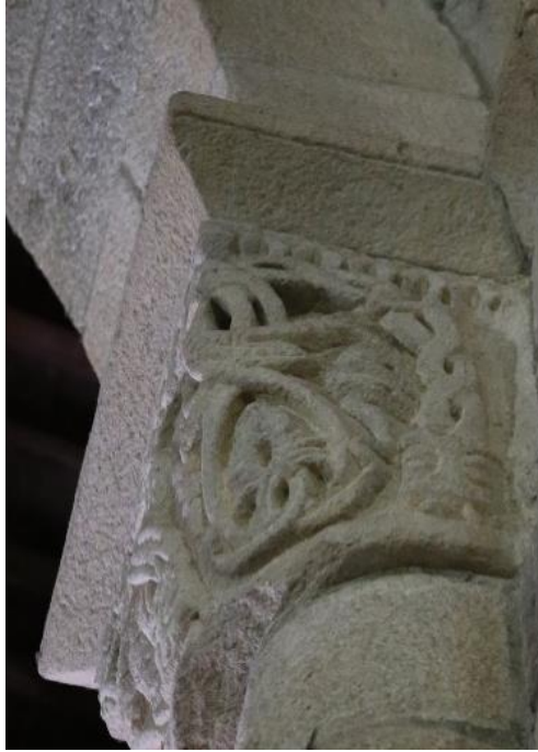
Figura 245 - Capitel da Nave Junto ao Transepto da Igreja de S. Pedro de Rates, Transição séc. XII-XIII, Autoria da Foto: Carolina Proença
