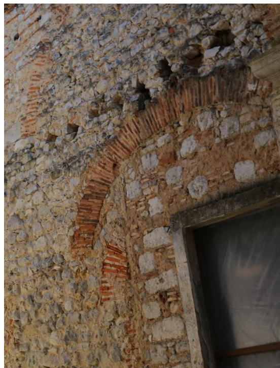
Figura 351 - Acesso Vedado à Capela das Almas pela Sala do Capítulo no Claustro Do Convento de S. Francisco de Santarém, Séc. XV, Autoria da Foto: Carolina Proença
