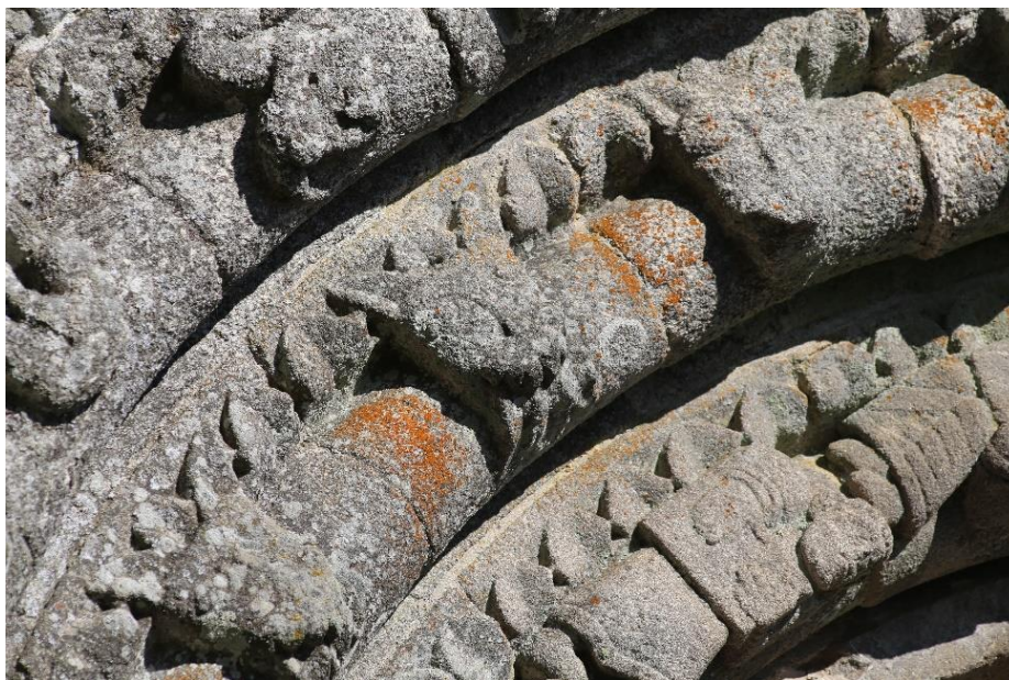
Figura 95 - Arquivolta do Portal Axial da Igreja de S. Salvador de Ansiães, c. 1180, A autoria da Foto: Carolina Proença
