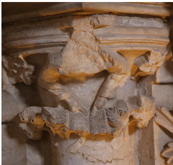
Figura 123 - Capitel do Coro-Alto do Convento de S. Francisco de Santarém, 1380-1383, Autoria da Foto: Carolina Proença
