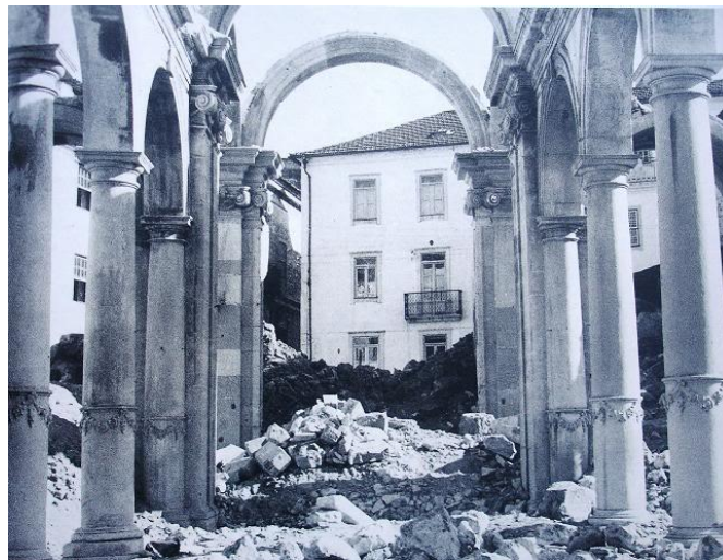
Figura 282 - Demolição da Igreja de São Pedro de Coimbra, 1945-1946, Fonte: Google
