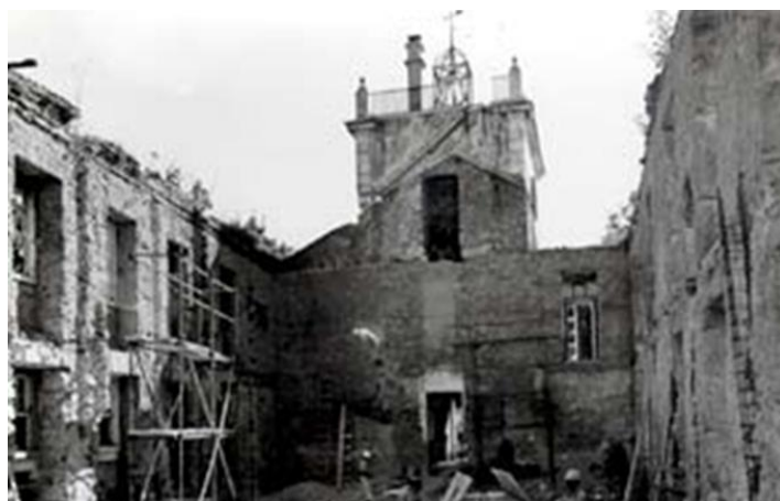
Figura 18 – Palácio do Monteiro-Mor pós incêndio.
