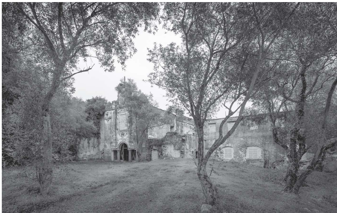
Fig. 6. Convento dos Capuchos, Setúbal: aproximação (2016). Fonte: José Manuel.
