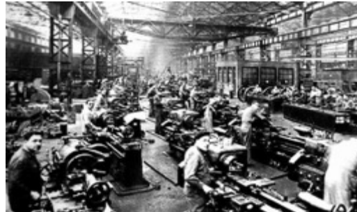
Fig. 21: Ferroviários a trabalhar no interior da Oficina.
