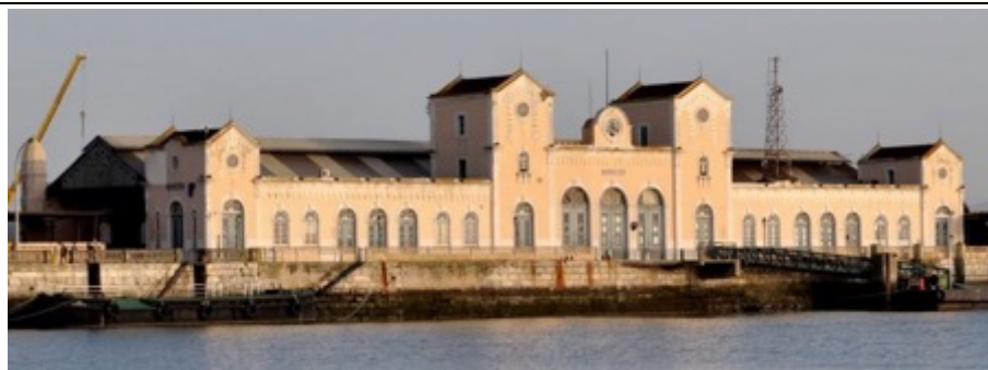
Fig. 28: Vista da fachada principal da Estação a partir do rio
