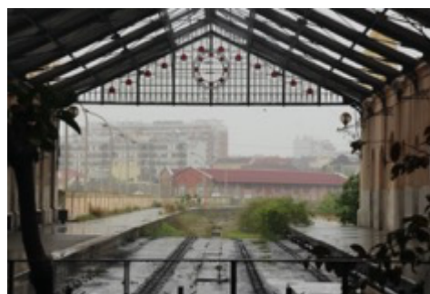
Fig. 30: Vista Interna da Gare da Estação Ferro-Fluvial
