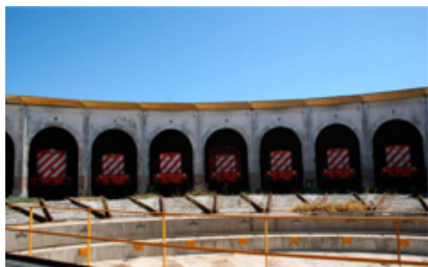
Fig. 33: Edifício da Rotunda das Máquinas, 2004.
