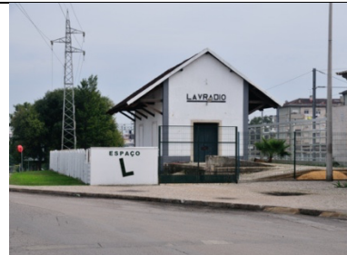
Fig. 79: Imagem Estação Lavradio
