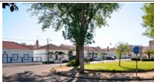
Fig. 38: Zona envolvente do Bairro Ferroviário.
