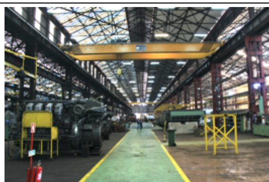
Fig. 19: Imagem interna da atual Oficina Geral, com vista da Gare e sua estrutura metálica.
