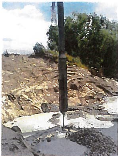
Melhoramento tradicional de solos moles aluvionares por colunas de brita
