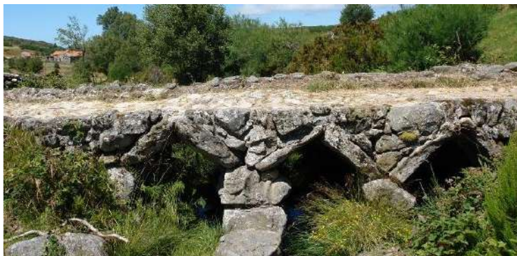
Figura 2.2 - Ponte "Celta" de Castro Laboreiro (Desconhecido, 2009)
