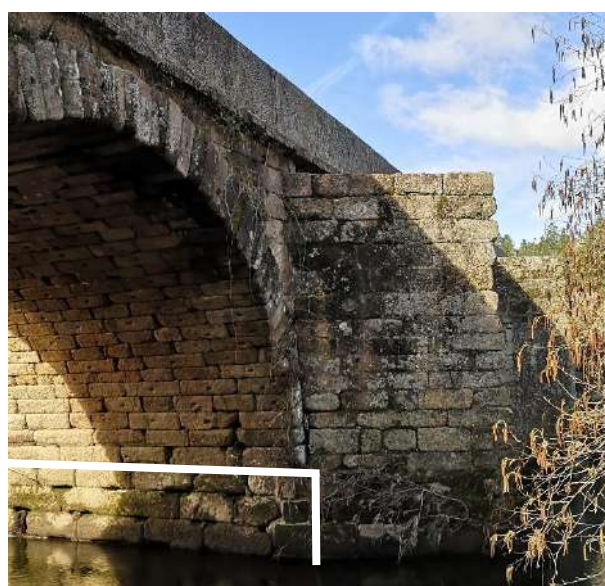
Figura 6.7 – Divisão entre pilar e arco; P4; alçado Norte; Encontro Este
