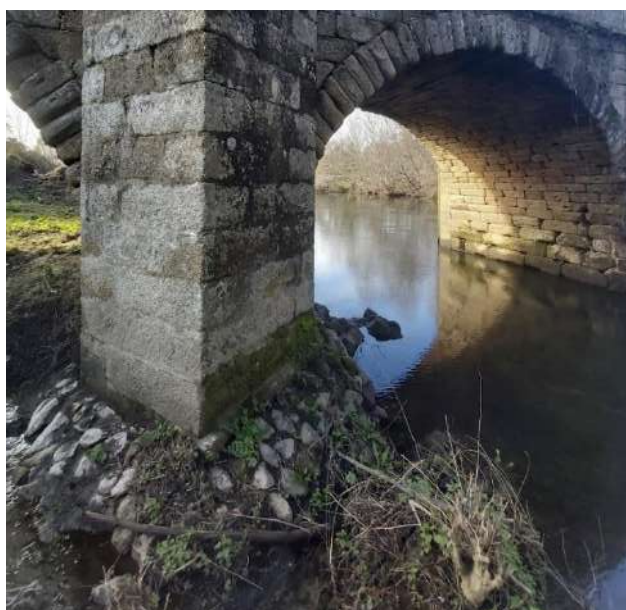
Figura 6.6 – Pormenor de enrocamento na base; P5; alçado Norte, Encontro Este
