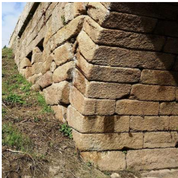
Figura 6.21 - Vista lateral do muro de tímpano Sul; Encontro Oeste
