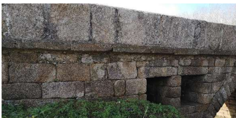
Figura 6.19 - Muro de tímpano Norte; Encontro Este
