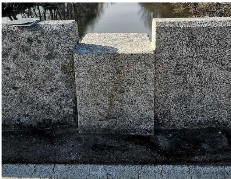
Figura 6.25 - Zona reparada na guarda Sul; P3
