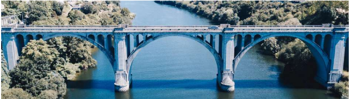
Figura 2.12 - Ponte Duarte Pacheco, Porto, Portugal (Multimédia, n.d.)
