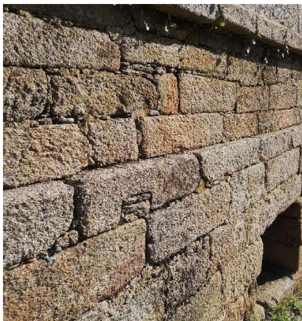
Figura 6.13 - Pormenor muro de tímpano no encontro Oeste, vista de Sul
