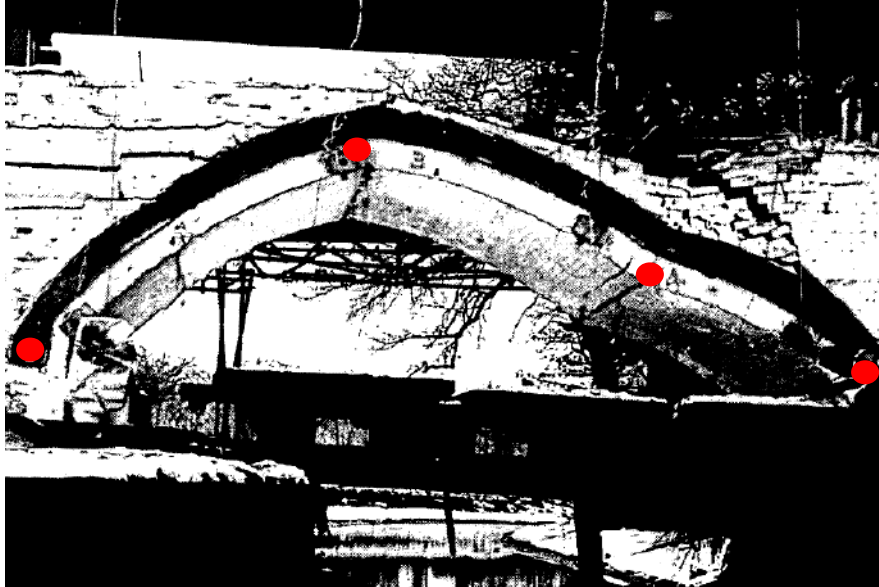
Figura 4.2 - Ponte de Prestwood momentos antes do colapso (J. Page, 1987)
