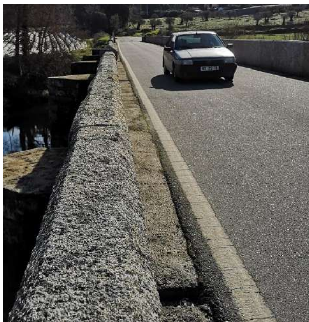
Figura 6.14 - Pavimento, guardas e gárgulas ao nível do tabuleiro
