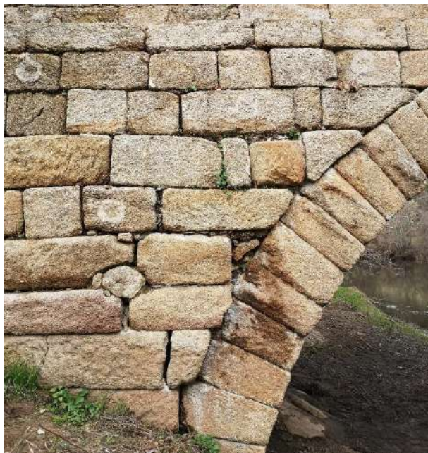
Figura 6.20 - Vista frontal do muro de tímpano Sul; Encontro Oeste
