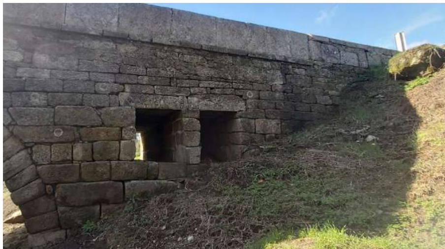
Figura 6.12 - Muro de tímpano situado no encontro Oeste, visto de Norte
