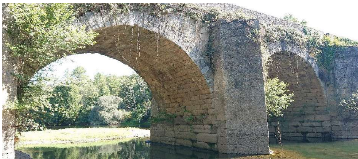
Figura 6.4 - Estrutura antes de ser desmatada; A1 e A2; Alçado Sul; Encontro Oeste
