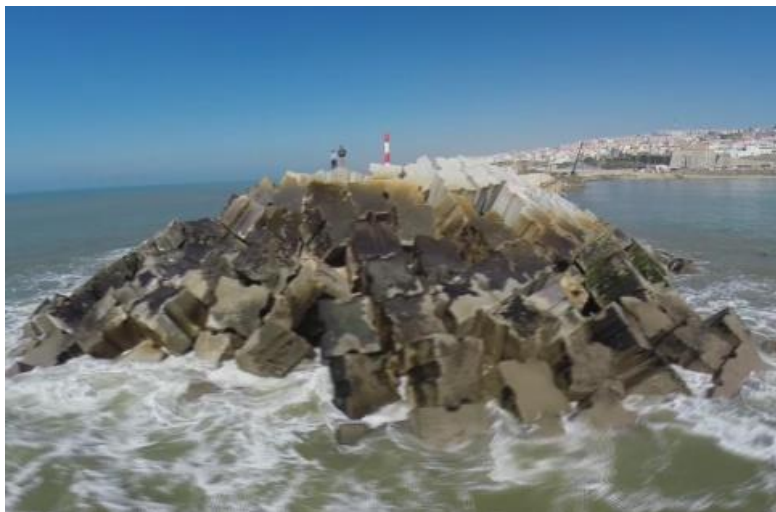
Figura 7 - Movimento de blocos em quebra-mar na Ericeira (Fonte: Ordem dos Engenheiros, 2015)
