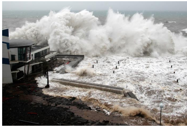
Figura 5 - Galgamento do quebra-mar em Ponta do Sol, Madeira (Fonte: [5], 2018)
