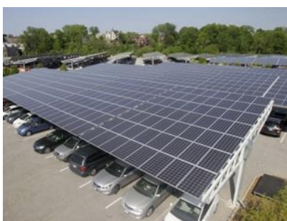
Figura 15. Parqueamento em painéis Solares. Fonte: Google Photos.
