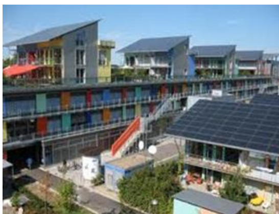
Figura 16. Telhados fotovoltaicos no Japão. Fonte: Google Photos.
