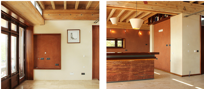
Figura 67 – Sala, em habitação contemporânea, com aplicação em determinadas áreas de barramento de argila, sobre reboco de terra. Olhão. Arquitectura: José Lima (OFICINA INTEGRADA). Execução: Joachim Reinecke (EMBARRO; com reboco “Embarro Universal” e barramento “Conlino”).
