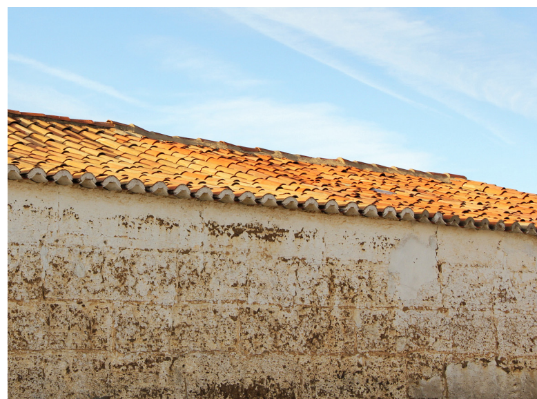
Figura 12 – Paredes de taipa com caiação directamente aplicada. Beja.
