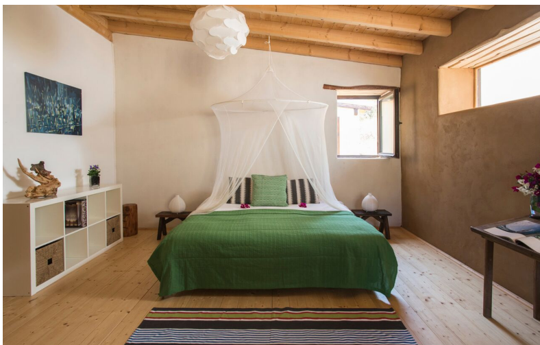
Figura 62 – Quarto, em obra contemporânea, com paredes de alvenaria de fardos de palha, revestidas com reboco de terra, acabamento por pintura de argila branca (parede esquerda e ao fundo) e consolidação com velatura de caseína (direita). Aljezur. Arquitectura e execução dos rebocos: Catarina Pinto (TERRAPALHA; com reboco “Embarro Universal”). Crédito: Vitor Lopes.
