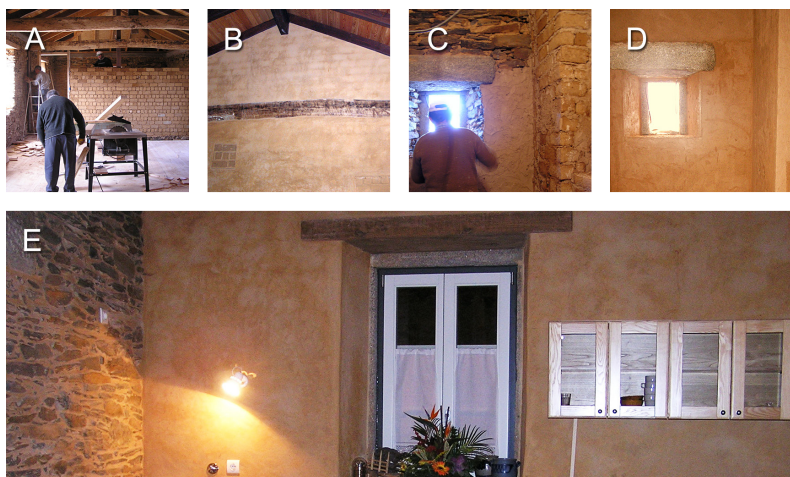
Figura 45 – Aplicação de reboco de terra, realizado com terra local, em obra de reabilitação. Arquitectura e crédito: Vera Schmidberger. (A, B) Aplicação sobre parede de adobe. (C, D) Aplicação sobre paredes de adobe e de pedra. (E) Aplicação sobre paredes de pedra.
