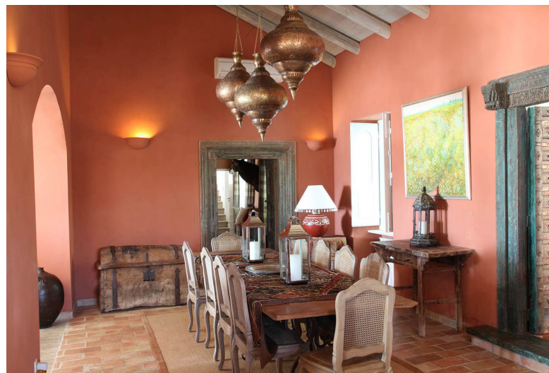
Figura 63 – Sala, em obra de reabilitação, com paredes em alvenaria de pedra, revestidas pelo interior com argamassa de reboco de terra pré-doseada e aplicação de barramento CONLINO, afagado, e acabamento por pintura, com tinta de argila CONLINO, de cor vermelha. Algarve. Arquitectura: Paola Boragine. Execução e crédito: Joachim Reinecke (EMBARRO, com reboco “Embarro Universal” e barramento e tinta de argila “Decofino”).
