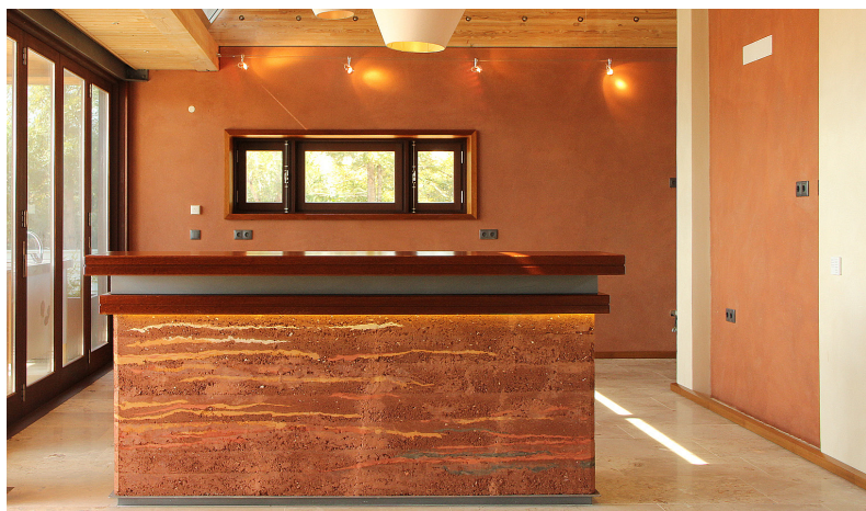
Figura 15 – Sala, em obra contemporânea, com paramentos interiores revestidos com reboco de terra sobre alvenaria de tijolo e acabamento “à vista”. Olhão. Arquitetura: José Lima (OFICINA INTEGRADA). Execução: Joachim Reinecke (EMBARRO; com reboco “Embarro Universal”).
