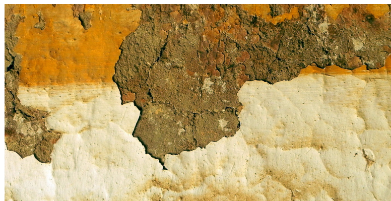
Figura 5 – Caição, com e sem pigmento, sobre reboco de terra em paramento de alvenaria de xisto. Almoinha, Mértola.
