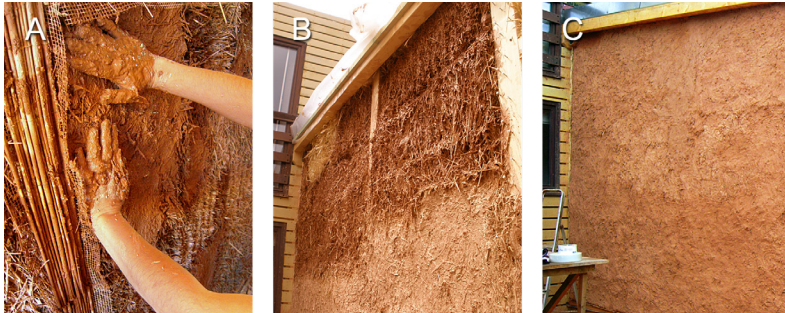
Figura 47 – Reboco de terra, formulado com terra do local, areia e palha de trigo, aplicado sobre parede realizada com fardos de palha, previamente salpicada com barbotina. Arquitectura e crédito: Catarina Pinto (TERRAPALHA).
