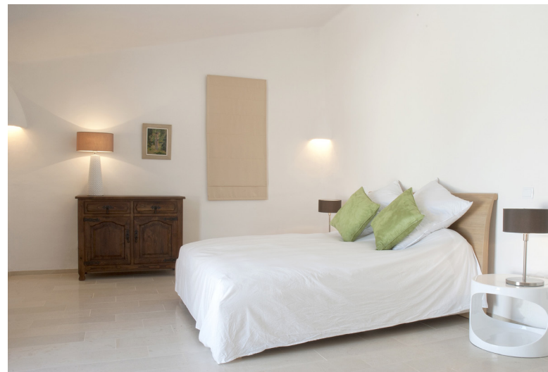
Figura 65 – Quarto, em obra contemporânea, com paredes em alvenaria de tijolo, revestidas pelo interior com argamassa de reboco de terra pré-doseada, com aplicação de barramento afagado e acabamento por pintura com tinta de caseína. Almancil. Arquitectura: Paola Boragine. Execução e crédito: Joachim Reinecke (EMBARRO; com reboco “Embarro Universal”, barramento “Conlino” e tinta “Kreidezeit”).
