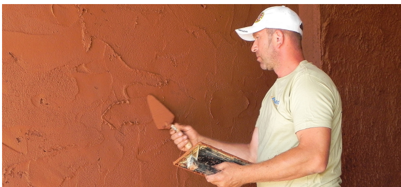
Figura 42 – Aplicação manual de camada de reboco com base em argamassa de terra pré-doseada sobre parede de alvenaria de tijolo térmico. Execução: EMBARRO, com reboco “Embarro Universal”.
