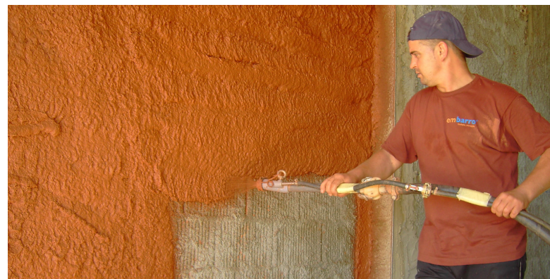
Figura 43 – Aplicação por projecção mecânica de reboco monocamada em argamassa de terra pré-doseada sobre parede de alvenaria de tijolo térmico, com aplicação prévia de salpico de argamassa de cal hidráulica natural. Execução: EMBARRO, com reboco “Embarro Universal”.
