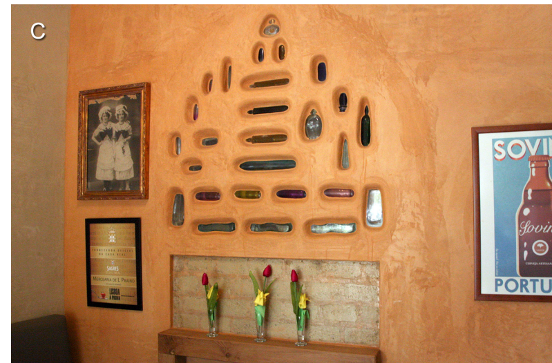
Figura 49 – Parede interior, realizada em espaço comercial em Telheiras, Lisboa, com recurso a modelação de argamassa de terra com inclusão de elementos em vidro. Arquitectura e crédito: Vera Schmidberger.
