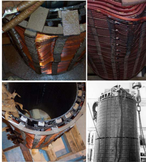
Figura 2.19: Exemplos de transformadores danificados por ação de free buckling (retirado de [19])
