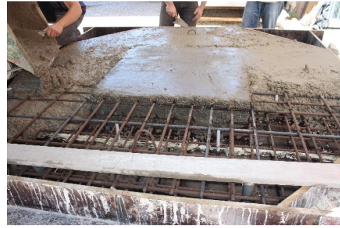
(b) Colocação do restante betão, neste caso normal sem fibras, no perímetro exterior.
