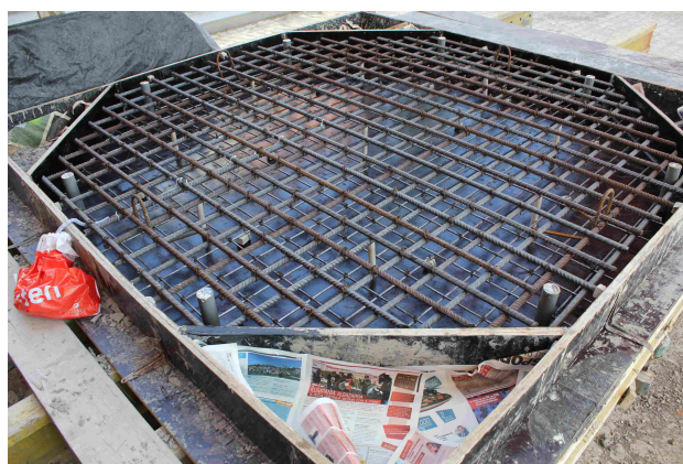
Figura 4.8: Foto com o aspeto final das armaduras longitudinais num dos modelos de laje antes da betonagem.
