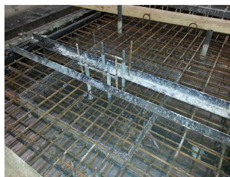
(b) Pormenor da rede metálica para colocação do BRFA.
