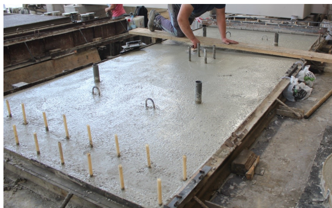
Figura 6.8: Aspeto geral de um modelo de laje após ser betonado.
