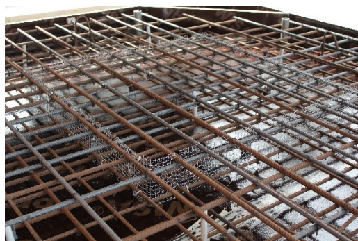
(b) Pormenor da rede metálica para colocação do BRFA.
