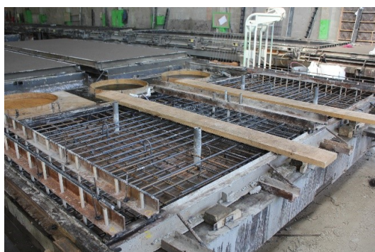
(a) Aspeto final das armaduras longitudinais na cofragem.
