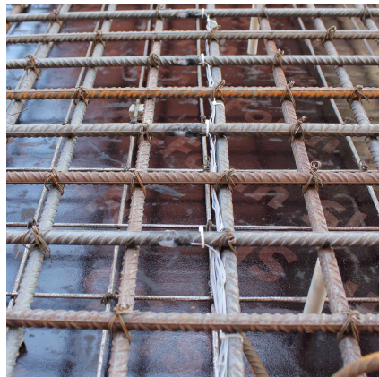
Figura 4.12: Extensómetros eléctricos localizados na armadura longitudinal superior, com silicone de proteção.
