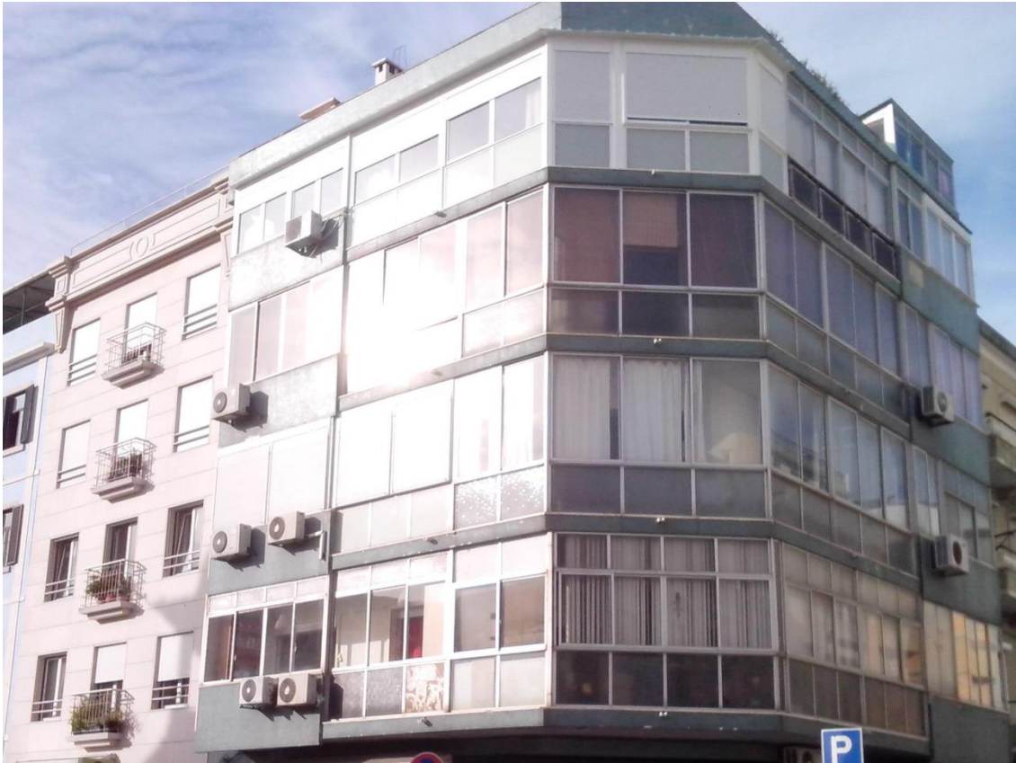
Fotografia 3 - Prédio com marquises em Campo de Ourique – fotografia do autor
