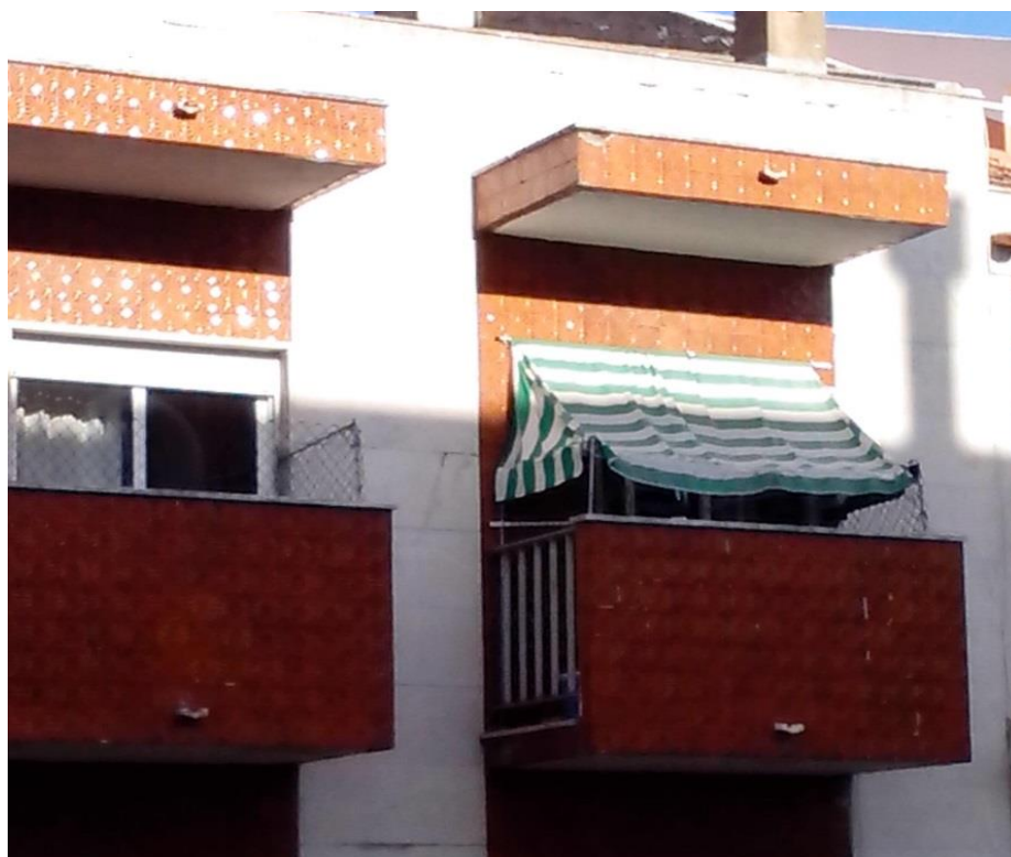
Fotografia 6 - Construções alternativas – fotografia do autor
