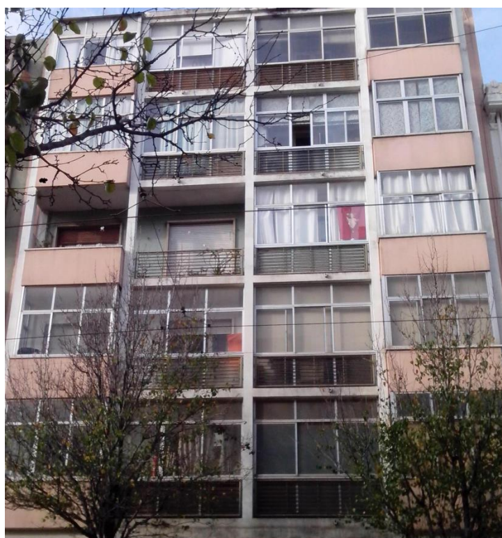
Fotografia 2 - Prédio com marquises em Campo de Ourique – fotografia do autor
