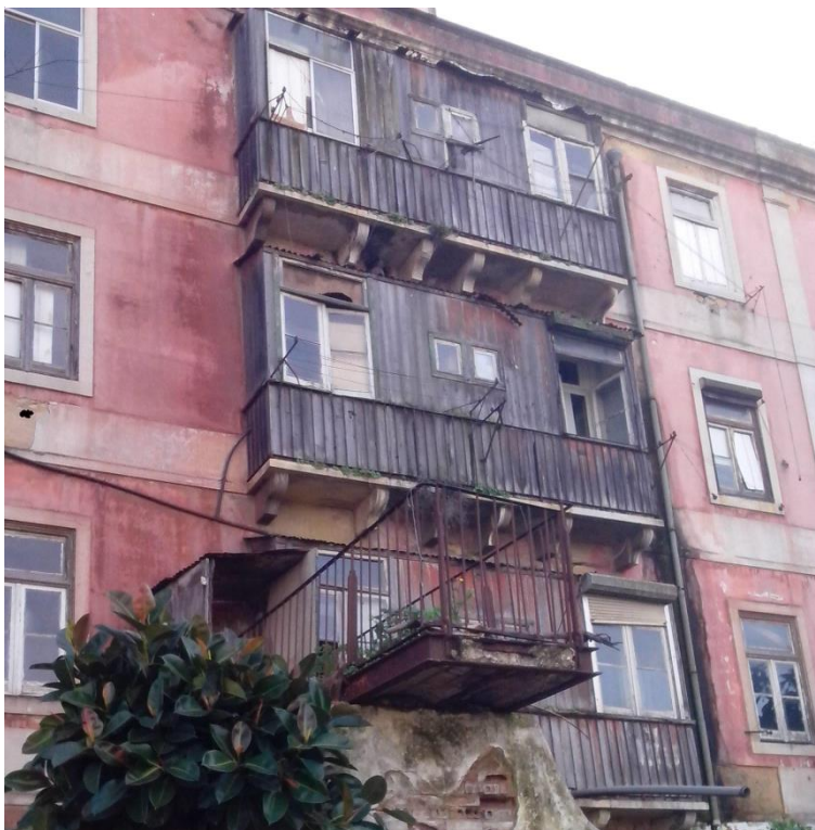
Fotografia 1- Possível marquise em madeira, Campo de Ourique – fotografia do autor
