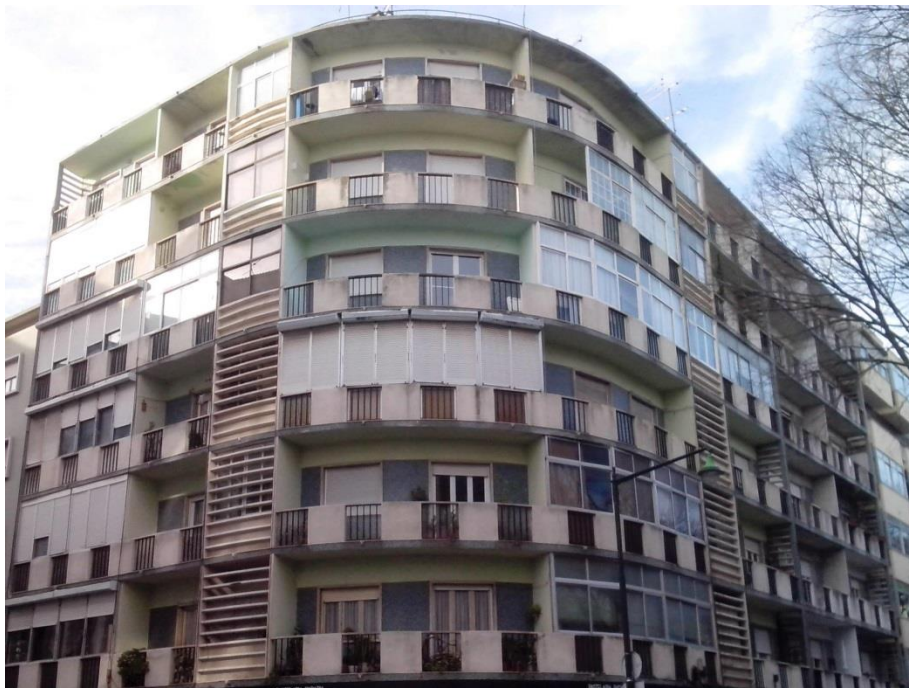
Fotografia 4 - Prédio com marquises em Campo de Ourique – fotografia do autor
