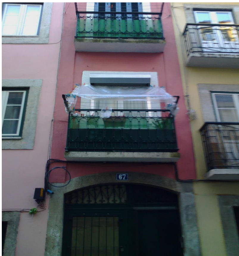
Fotografia 5 - - Construções alternativas – fotografia do autor
