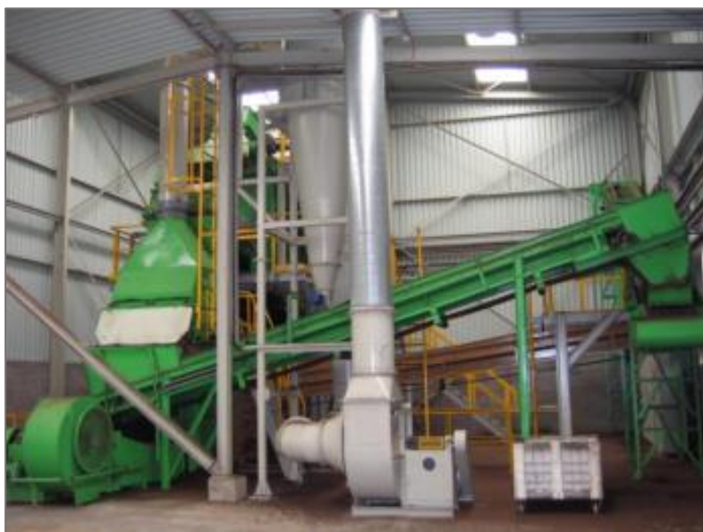
Figura 5.7 - Edifício de afinação.
