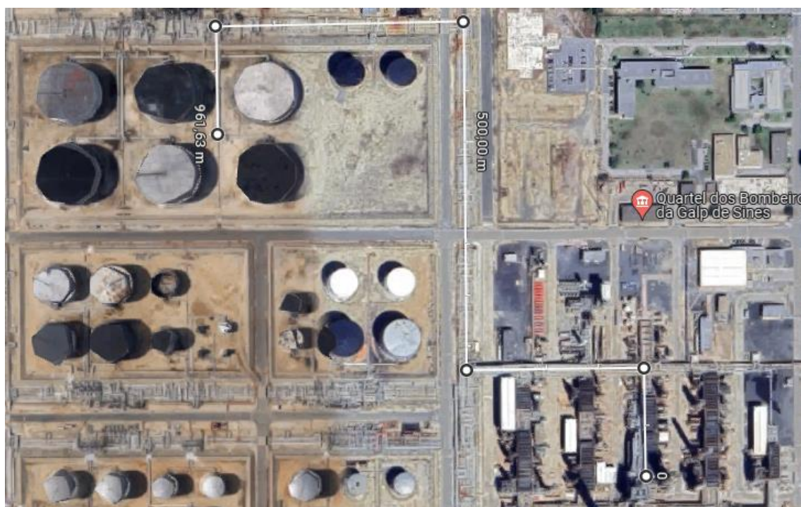
Figura 3.11 - Tubagem existente na refinaria para armazenagem do resíduo atmosférico
