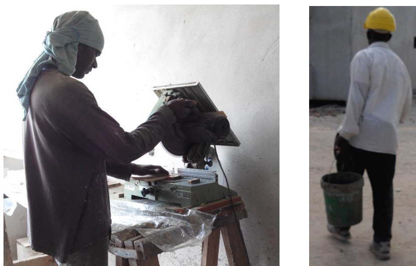
Figura 6.1 – Exemplos de atividades com risco de causar constrangimentos físicos no corpo
