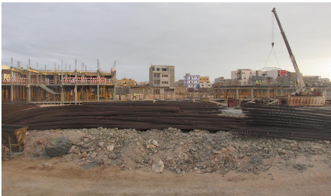
Figura 5.6 - Armação de ferro e colocação das armaduras
