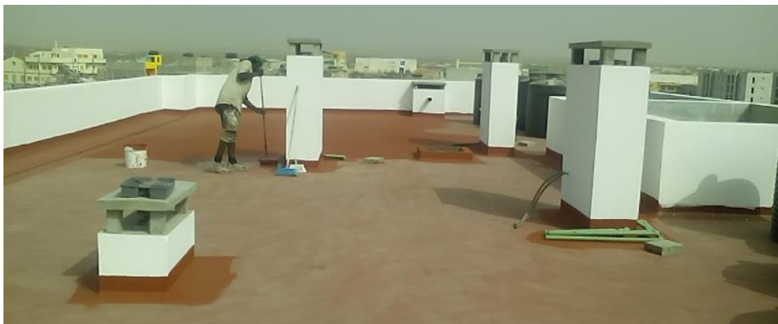
Figura 5.10 - Impermeabilização da cobertura
