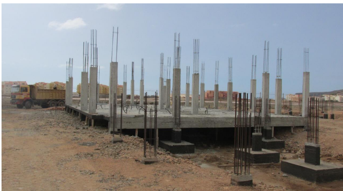
Figura 5.3 - Arranque de prédio com sapatas, laje térrea, primeiro e segundo troço de pilares
