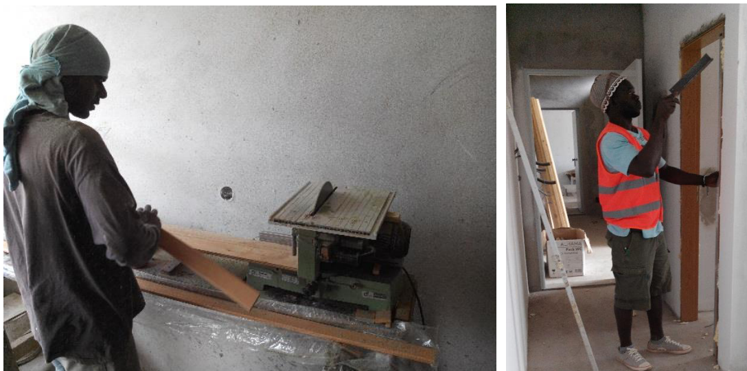
Figura 5.12 - Corte e montagem de aro de porta
