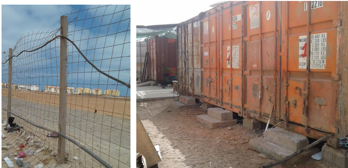
Figura 5.4 - Vedação e contentores
