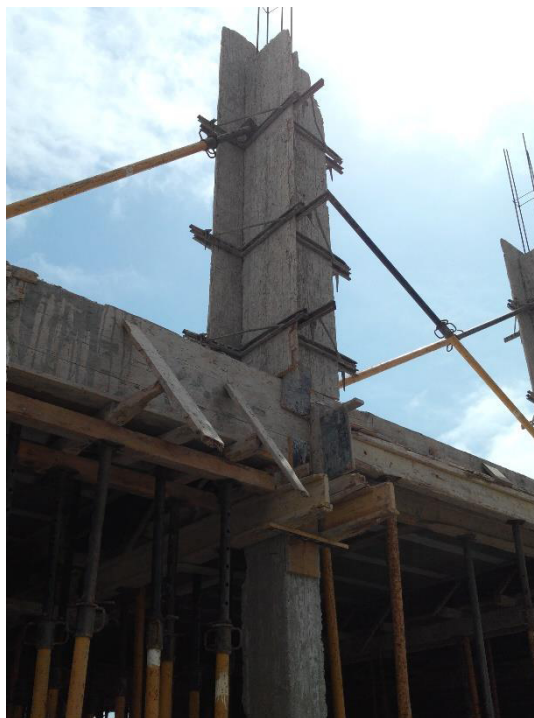
Figura 5.7 - Cofragem de um pilar
