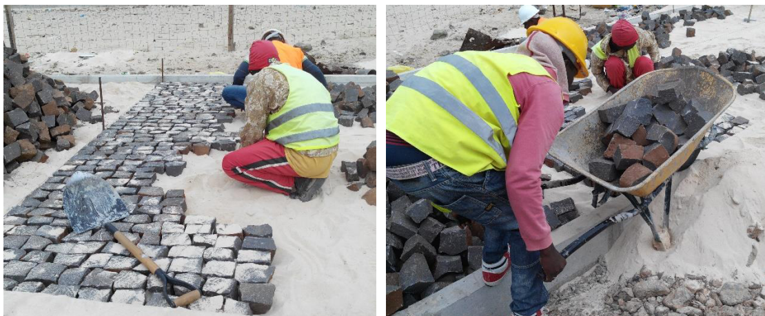
Figura 5.13 - Construção de arruamentos
