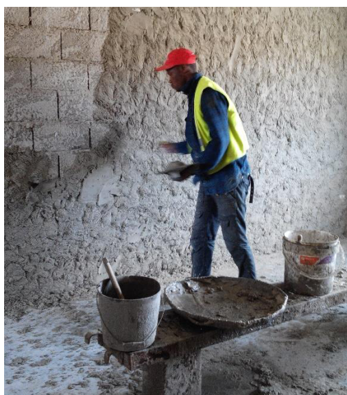
Figura 5.8 - Execução de reboco
