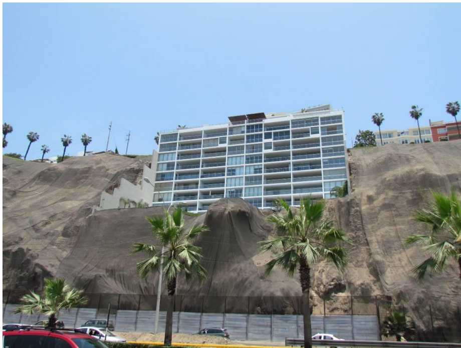
Fig. 8: Vista desde la parte inferior del acantilado del edificio de apartamentos Infinity. Fuente: Adondevivir (S/F).
