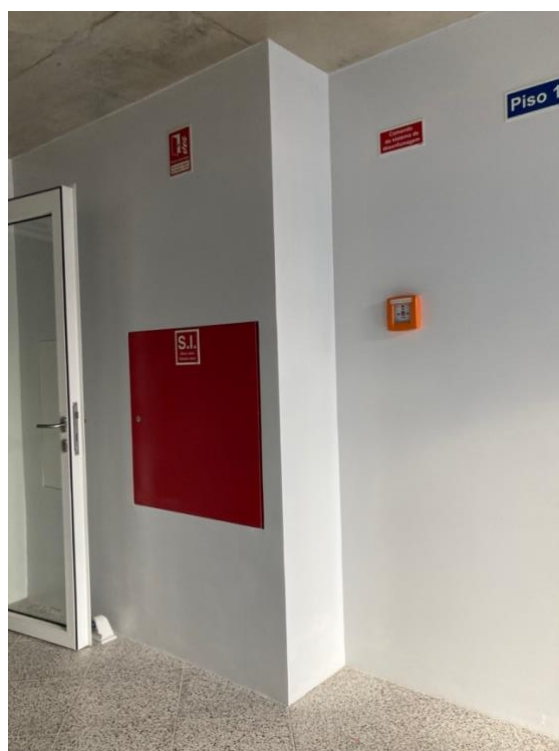
Figura 4.17 – Acesso comum às escadas do edifício.
