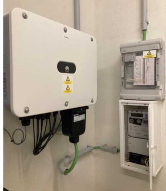
Figura 4.6 – Inversor e contador de produção.
