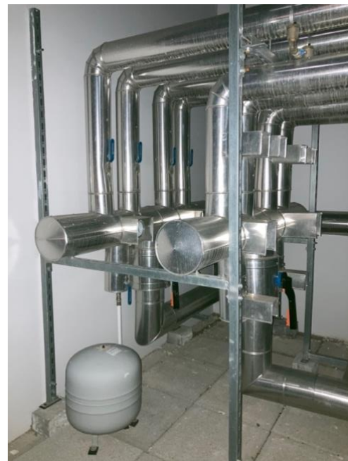
Figura 4.8 – Tubagem do sistema.
