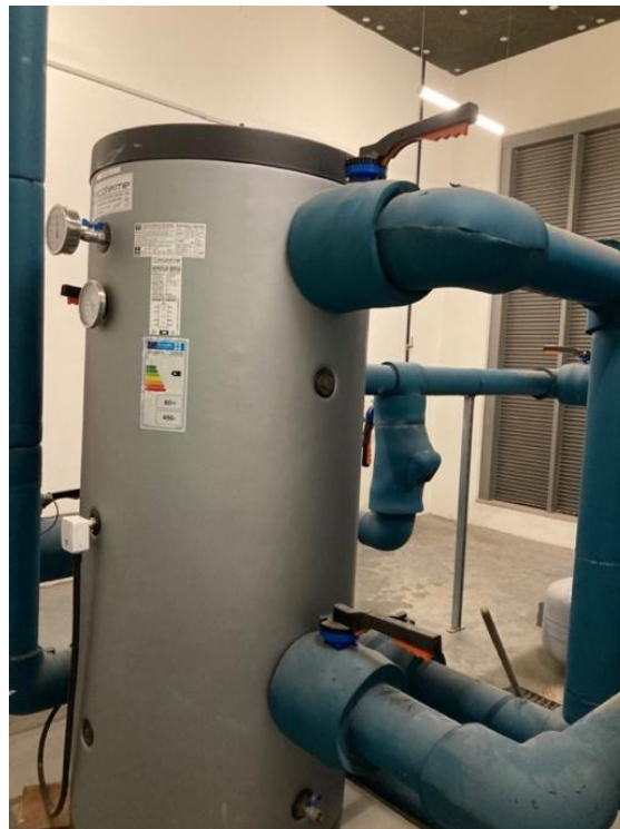
Figura 4.9 – Depósito de inércia, modelo DI 500 VSL.
