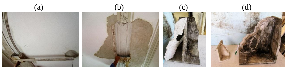
Figura 3. Execução de elementos corridos in situ : moldura redonda (a); moldura reta (b); forra para correr argamassa de esboço (c); molde de grande dimensão (d).
