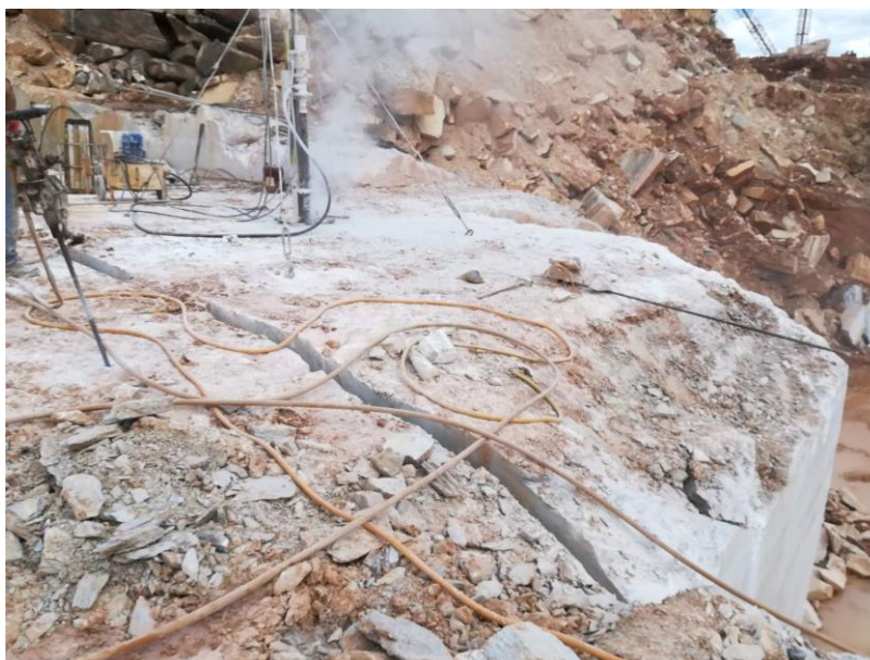
Figura 4.5. Operações unitárias de perfuração realizadas na pedreira (Fonte: B Stone - Marble, 2016).
