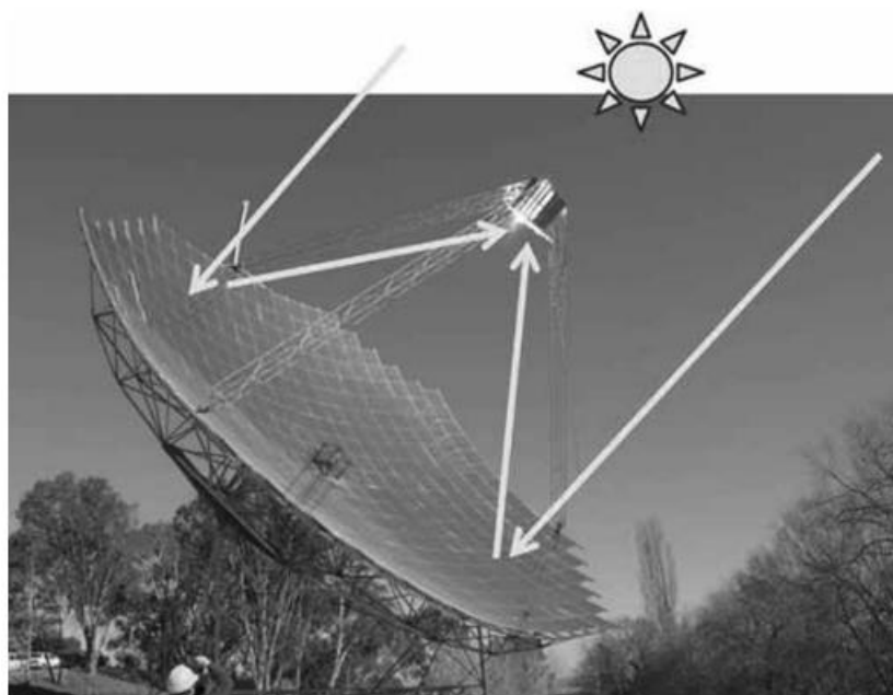
Figura 10 - Coletor em Disco Parabólico da Australian National University , 500 m 2 [48].
