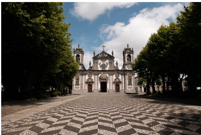
Fig. 220: Fachada principal da igreja do Bom Jesus de Matosinhos. Foto: IMA.
