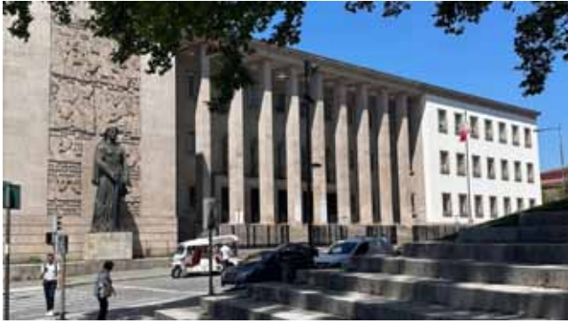
fig. I.AR 19 Raúl Rodrigues Lima (1909-1980) Palácio da Justiça do Porto, 1961 Vista exterior Fotografia © Letícia Crespillo, 2024
