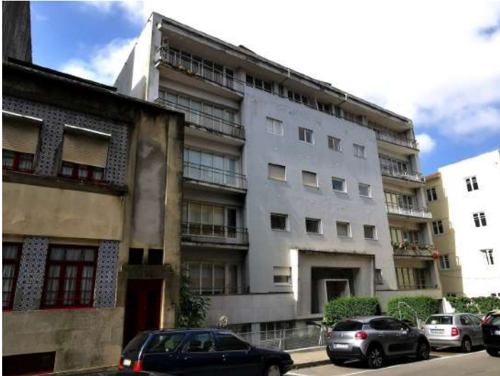
fig. I.AL 11 Arménio Losa e Cassiano Barbosa Bloco da Carvalhosa (Porto, 1953) Vista exterior Fotografia © Sónia Moura, 2021
