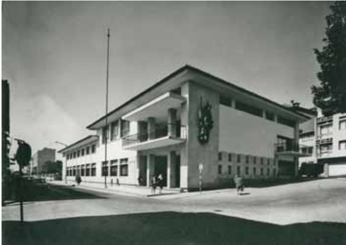
fig. I.ET 13 Carlos Chambers Ramos (1897-1969) Palácio da Justiça de Oliveira de Azeméis, 1965 Vista exterior Fotografia cortesia Rita Maia Gomes
