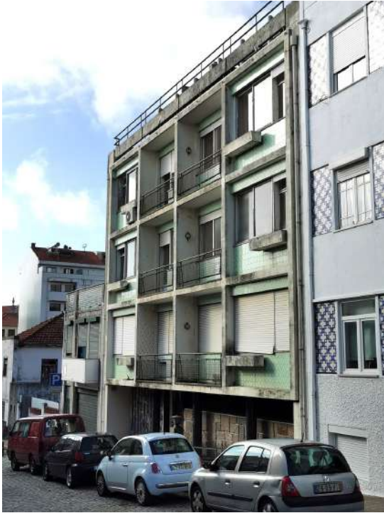
fig. I.AL 23 Arménio Losa e Cassiano Barbosa Edifício Custódio F. Lino (Porto, 1951-1953) Vista exterior Fotografia © Sónia Moura, 2021
