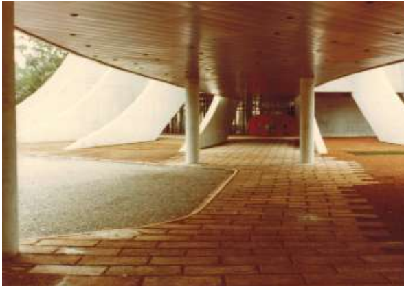
fig. I.AVL 9 José Rodrigues Esculturas em chapa recortada e pintada instaladas à entrada Fundo Viana de Lima CDUA-FAUP VL ARQ 100-env07_F100
