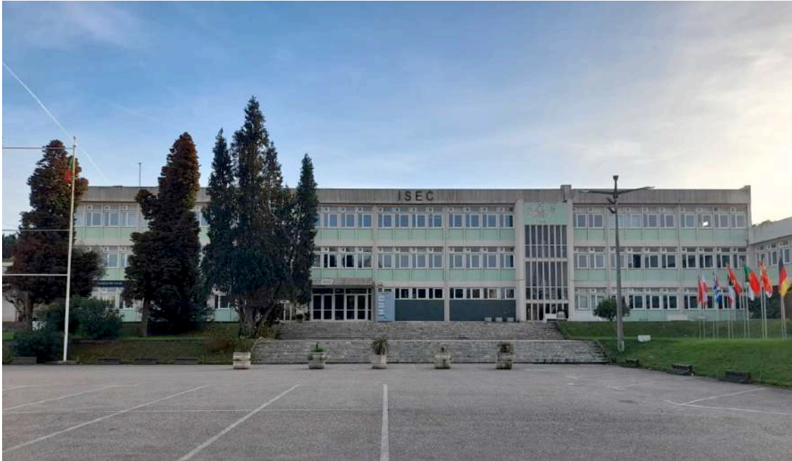
fig. I.VD 2 Instituto Industrial de Coimbra (1967-1972) [Actual Instituto Superior de Engenharia de Coimbra] Vista exterior Fotografia © Luisa Barbosa Cardoso, 2024
