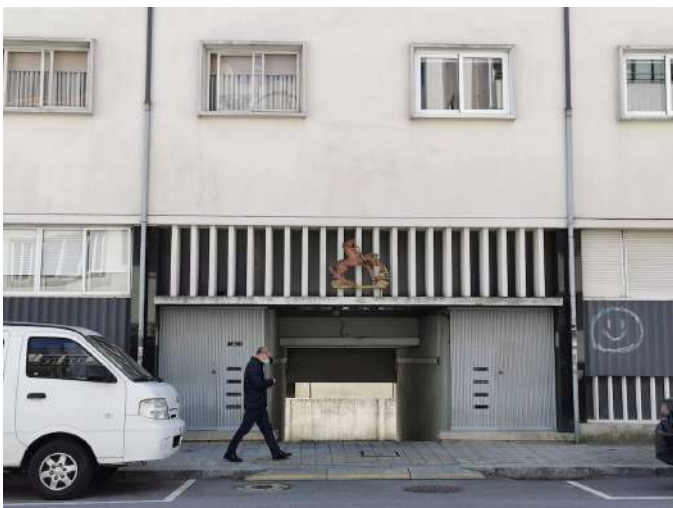
fig. I.AL 20 Arménio Losa e Cassiano Barbosa Bloco da Constituição (Porto, 1951) Vista exterior [Integrando escultura de Eduardo Tavares] Fotografia © Sónia Moura, 2021
