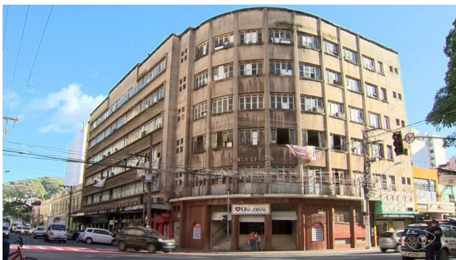
Figura 22 - Edifício Santa Cecília, Centro de Vitória, 2017
