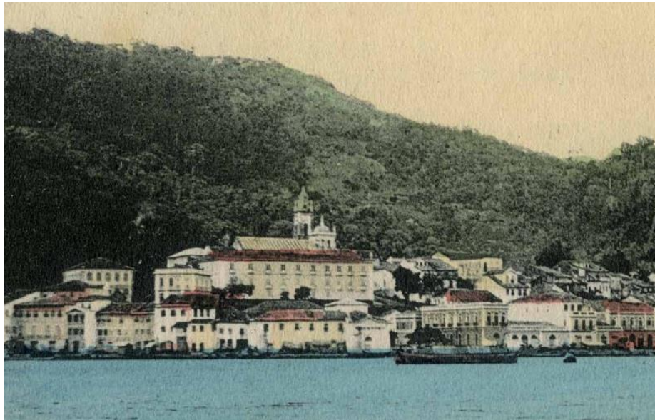
Figura 27 - Colégio São Tiago recuperado, após incêndio
