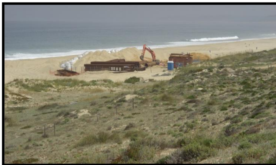
Figura 3.14 - Empreitada de construção do emissário final da ETAR de Lagoa/Meco sobre a duna embrionária do sistema dunar da Praia do Meco (Fotografia: Cátia Sousa, 2010).
