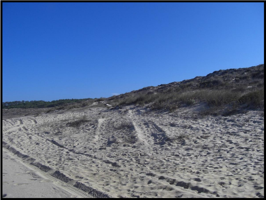
Figura 11 - Local onde decorreu a empreitada de construção do emissário final da ETAR de Lagoa/Meco, 29-09-10. Notar a destruição das dunas embrionárias e as marcas de pneus (Fotografia: Cátia Sousa, 2010).
