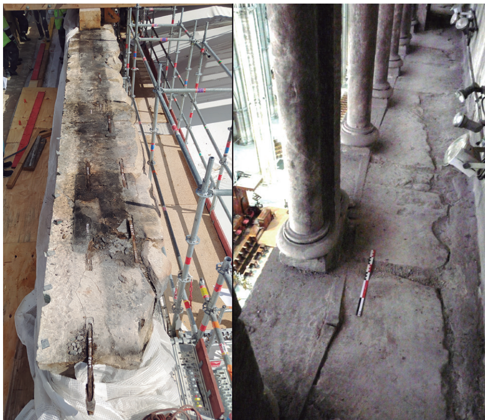
Fig. 5 – Agrafes au sommet des murs gouttereaux du chevet de Notre-Dame de Paris (à gauche) et chaînage au sol du triforium du chevet de la cathédrale de Bourges (à droite).
