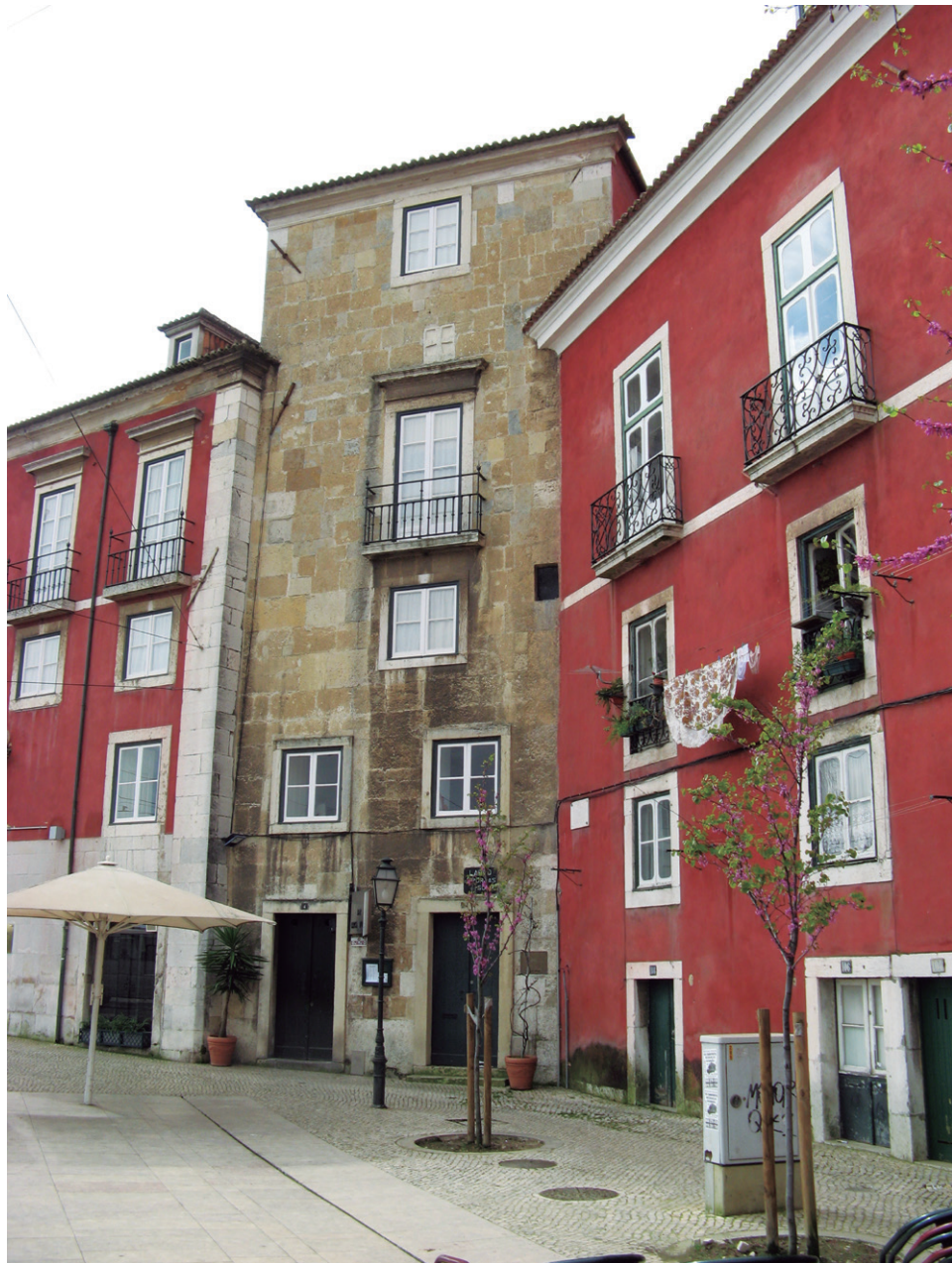
Fig. 1 – Torre da muralha no Largo das Portas do Sol (Foto: Manuela Leitão).
