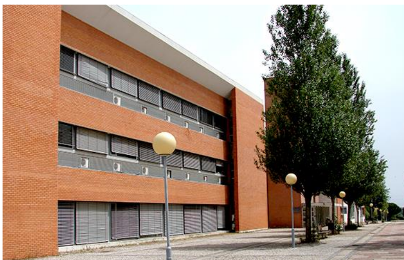
Figura 3.1 - Fachada Oeste edifício [37]
