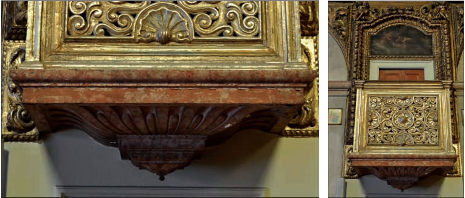
[Fig.10] Vista da bacia do púlpito em obra pétreia fingida | View of the pulpit base with stone like painting
