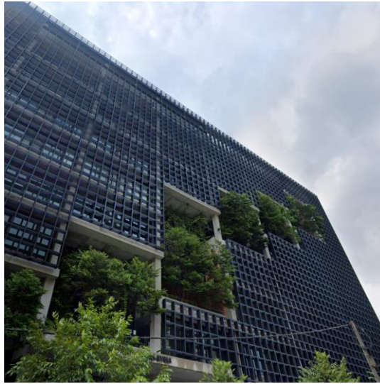
Figura 2.16 - Solução de Eggcrate: Pertubuhan Arkitek Malaysia (PAM) em Bangsar, Kuala Lumpur (Adaptado de [50])
