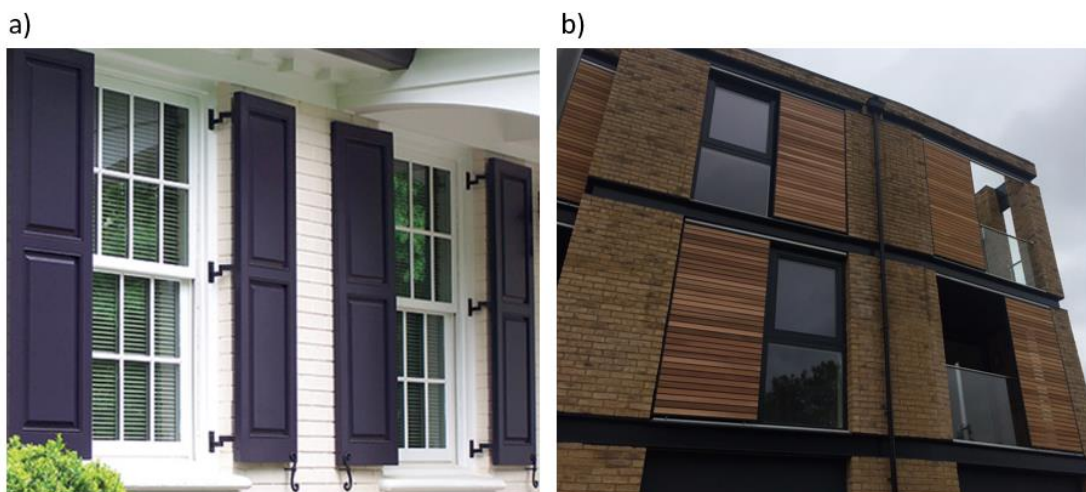
Figura 2.25 - Sistema de abertura de portadas: a) Batente (Adaptado de [61]); b) Correr (Adaptado de [62])
