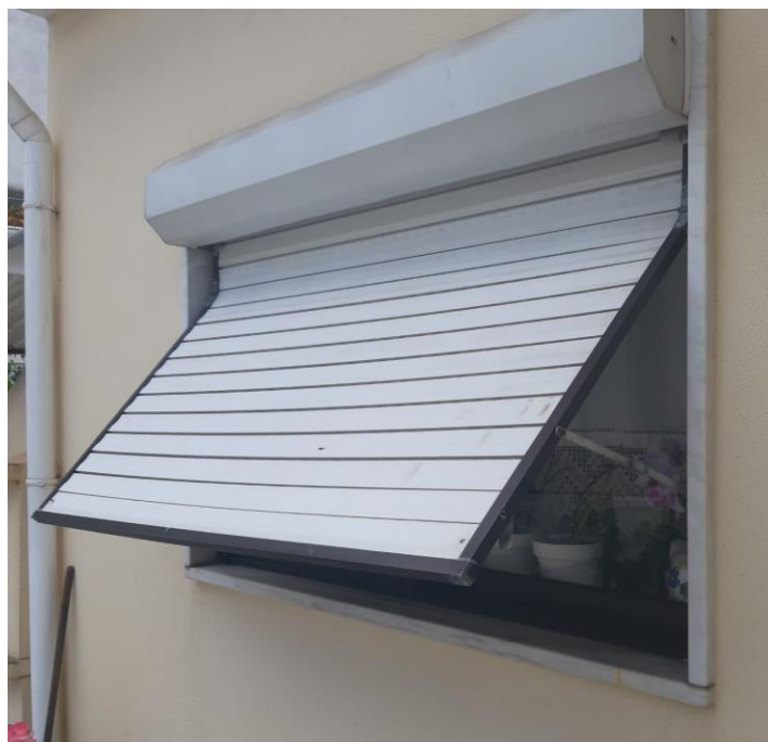
Figura 2.21 - Persiana com mecanismo de projeção.
