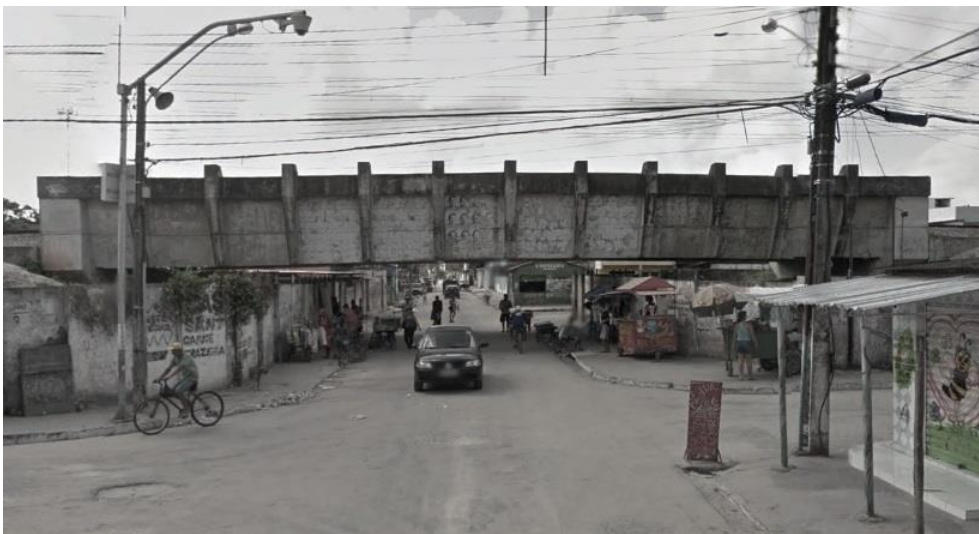
Figura 4.14 - Passagem por baixo da linha ferroviária. Fonte: Google
