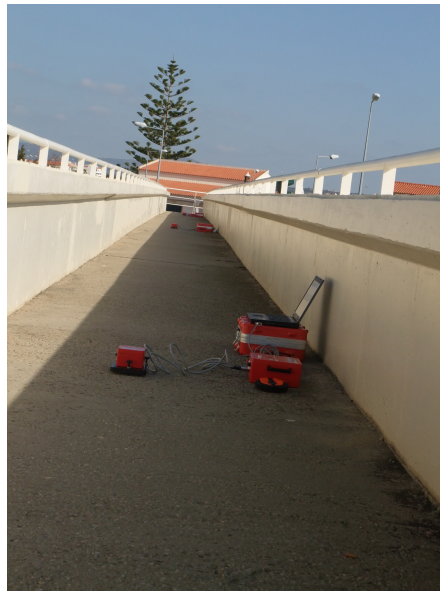
(b) Disposição ao longo do passadiço, dos três sistemas utilizados
