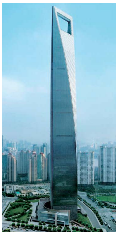
(a) Vista do edifício
