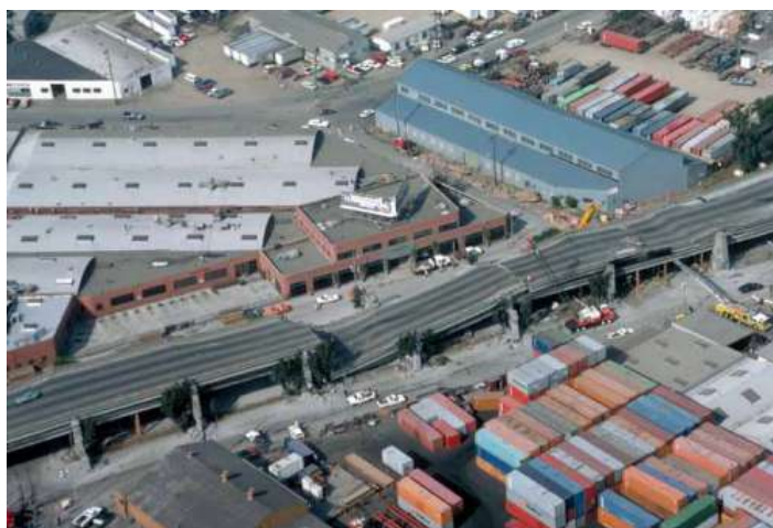
(a) Vista geral do viaduto “Cypress”
