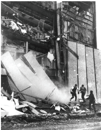
Figura 11.25 Os painéis de fachada nesta loja em Anchorage colapsaram no sismo do Alasca de 1964 [fonte: EERC]
