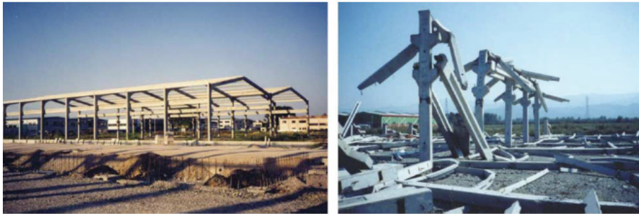
Figura 11.21 Estado do edifício antes e após o sismo de Kocaeli em 1999 na Turquia [3].
