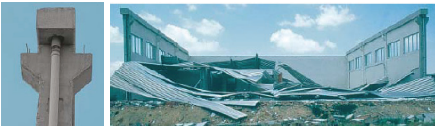
Figura 11.19 Os ferrolhos no topo dos pilar (à esquerda) não permitiram a estabilidade das vigas principais, o que levou ao seu derrube e conseqüente colapso do edifício industrial durante um sismo em 1998 na Turquia [2]
