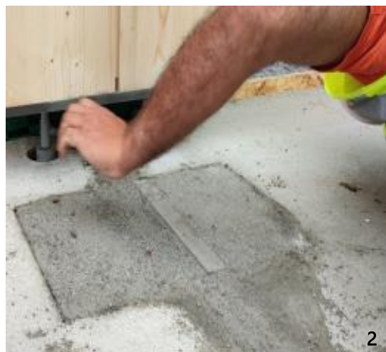
1 - Tirante em varões de aço; 2 - Caixa do tirante preenchido com grout
