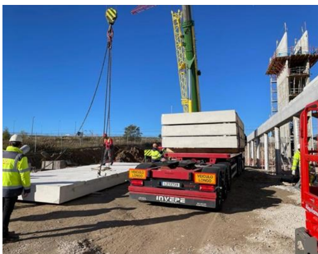
Figura 5.39 — Transporte de painéis modulares
