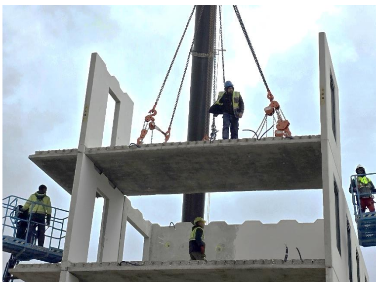
Figura 2.13 — Encaixe do Módulo 3D em betão
