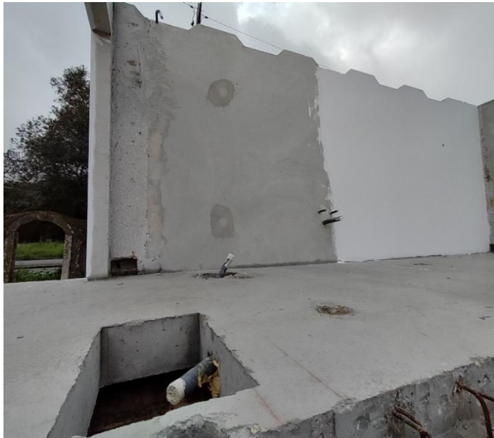
Figura 5.57 — Residência de estudantes - Negativos para instalação de redes de águas
