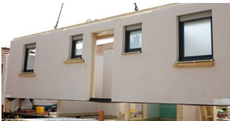
Figura 2.9 — Módulo 2D, fachada com janelas
