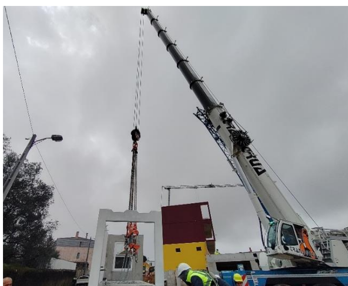
Figura 5.56 — Residência de estudantes - Grua de elevação de módulos de betão
