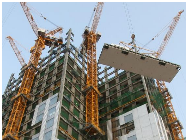
Figura 2.8 — Módulo 2D, Laje
