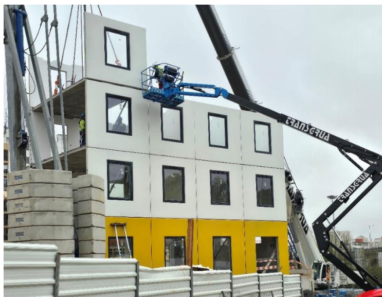
Figura 5.53 — Residência de estudantes - Montagem da fachada principal e plataforma de elevatória
