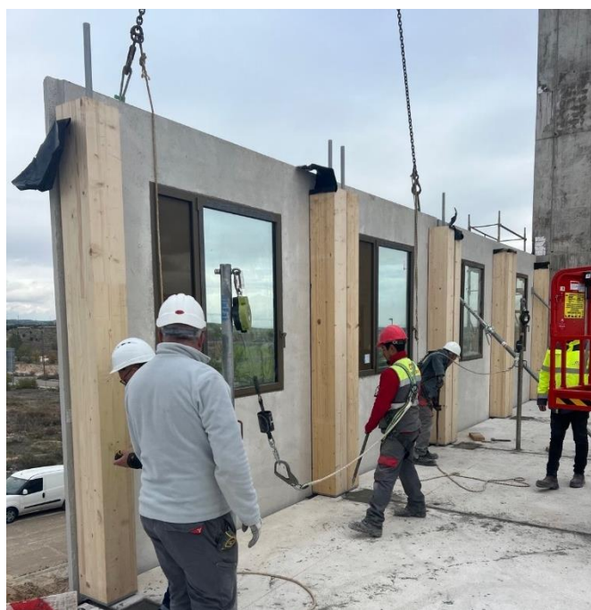
Figura 5.35 — Painéis de fachada principal em conclusão de montagem
