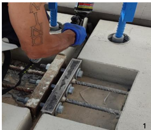
1 - Tirante em varões de aço; 2 - Caixa do tirante preenchido com grout
