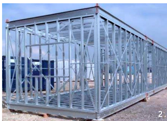
1 - Módulo continuamente apoiado em aço leve; 2 - Módulo de suporte de canto
