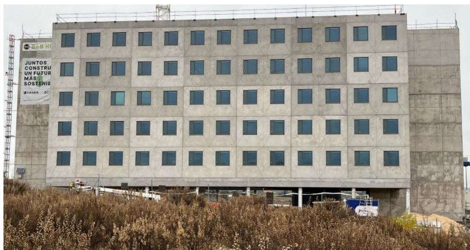
Figura 5.47 — Fachada do hotel "Tres Cantos", em Madrid finalizada
