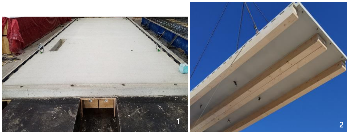
1 - Vista da laje mista corrente terminada; 2- Vista inferior da mesma laje
