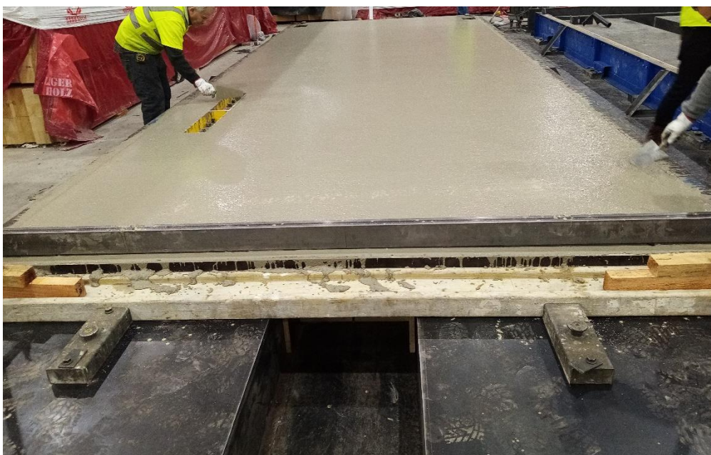
Figura 5.44 — Produção da laje após a betonagem
