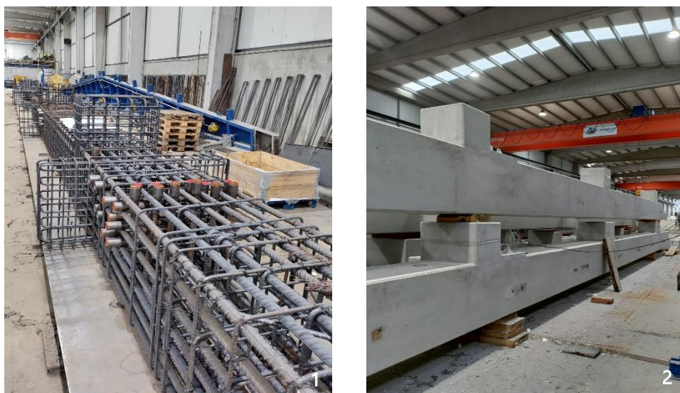
1 - Armadura de um pilar produzido em fábrica; 2 - Pilar já betonado em fábrica
