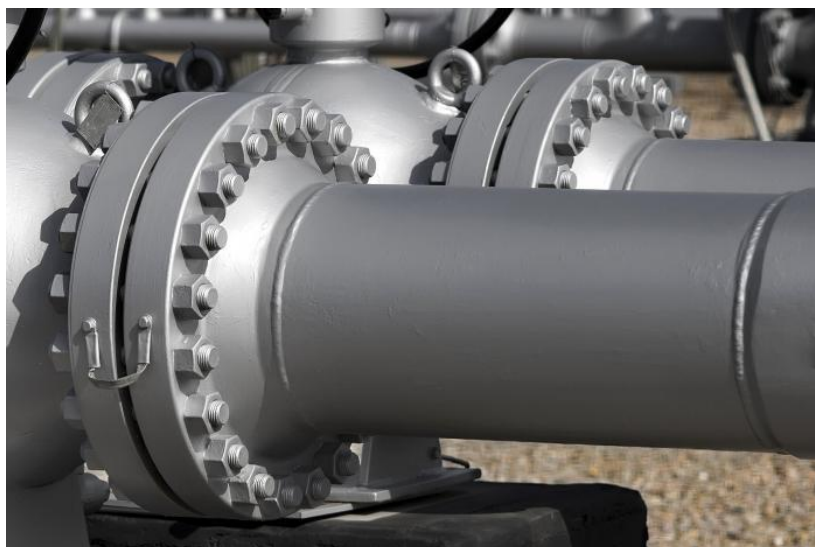
Figura 4.1 – Ligação flangeada. Retirado de [9].
