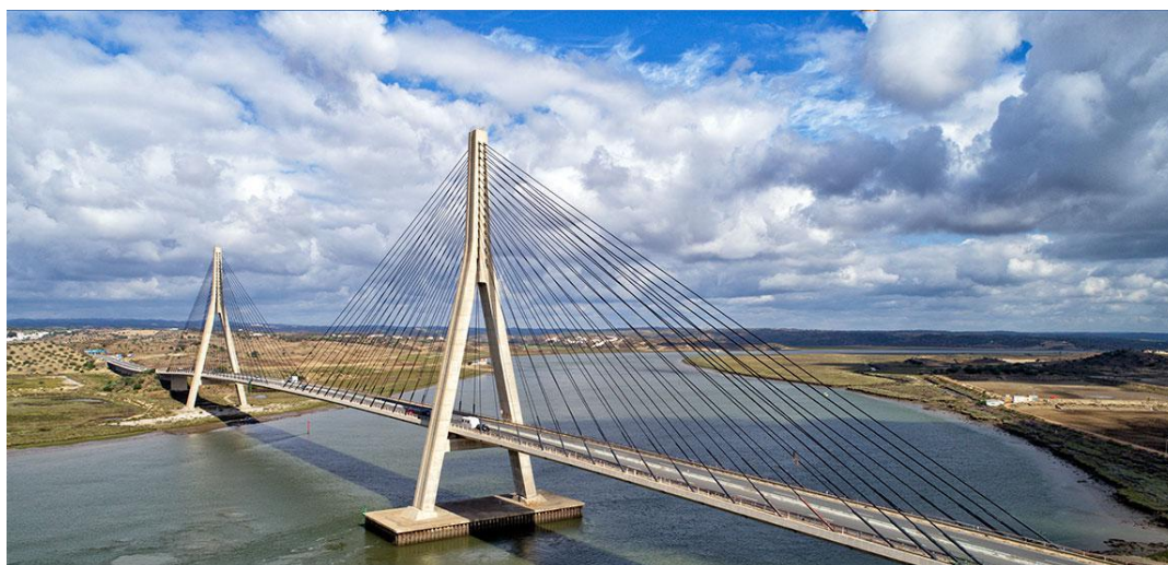
Figura 5.3 - Ponte Internacional Sobre o Rio Guadiana. Retirado de [13].
