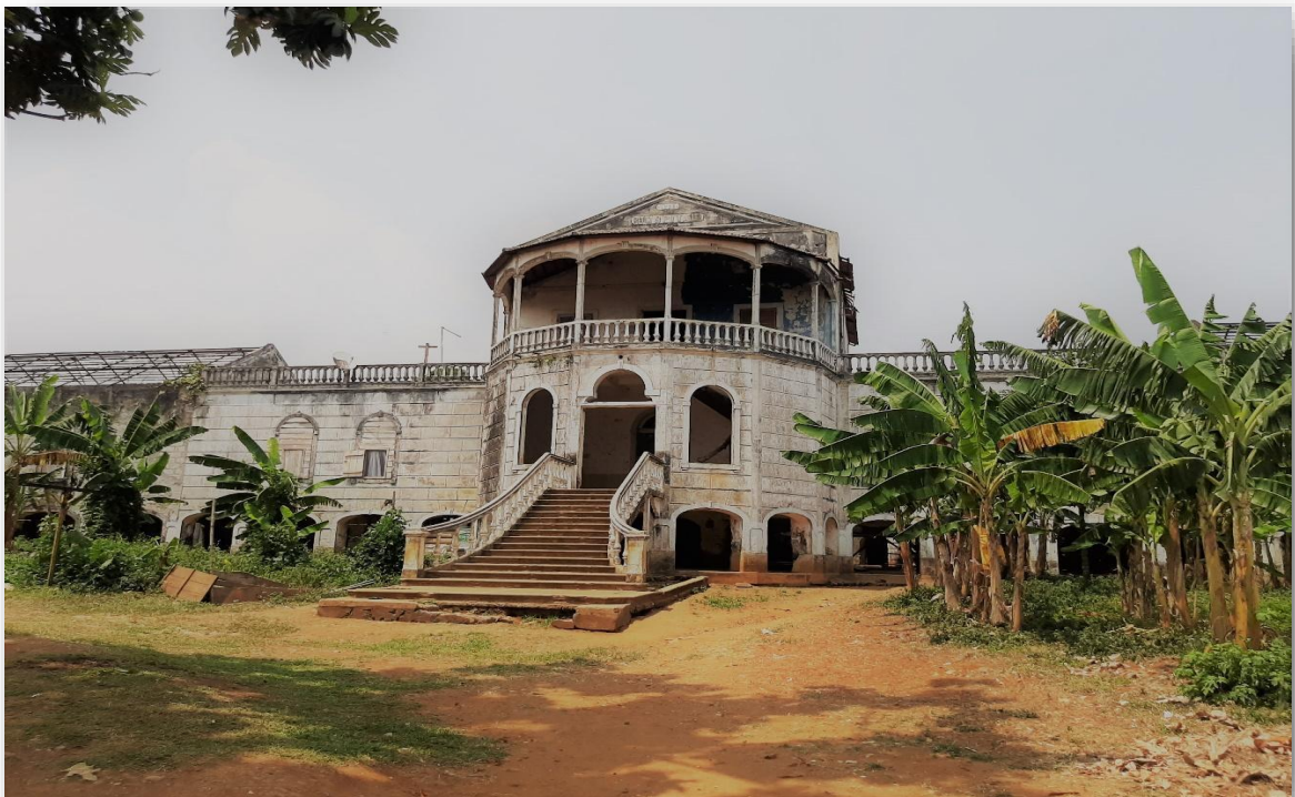
Fig. 43. Hospital da Roça Água Izé.
