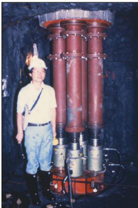
Figura 2.23 – Ensaio de carga em placa aplicado numa galeria de prospecção para a exploração hidroeléctrica de Tienlun (Taiwan) [18]
