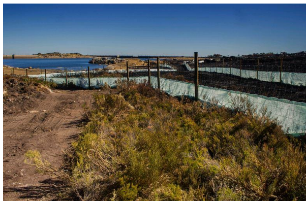
Figura 9 – Membrana Geotêxtil, albufeira da Barragem do Viriato. Fonte – CMC.
