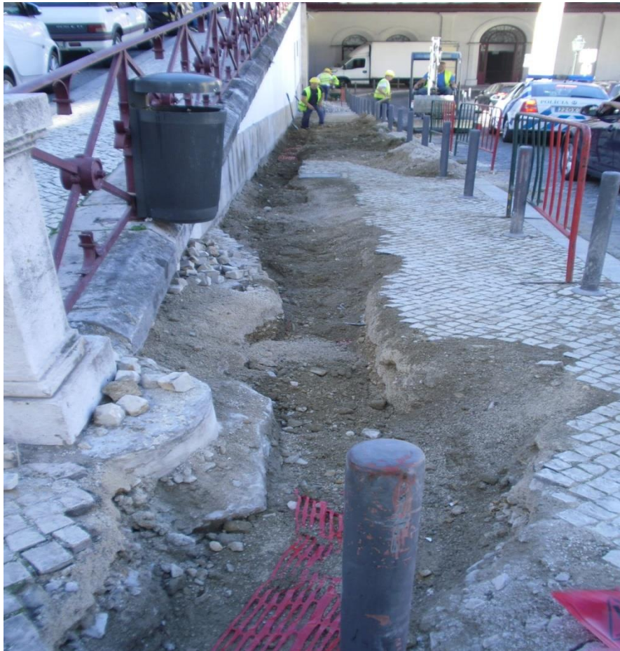
Fig.13 – Preenchimento das valas com os sedimentos retirados (Autoria: Equipa Neoépica)
