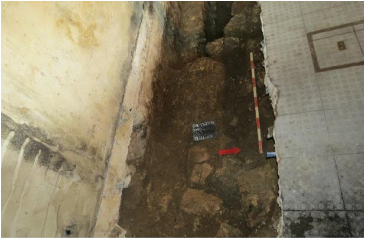
Fig. 68 – Conduita identificada na sondagem 2. no edifício n.º93 da Rua dos Bacalhoeiros (Autoria: Equipa Neoépica)
