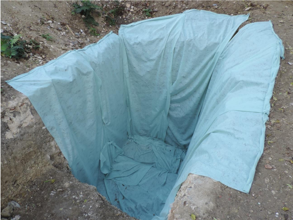
Fig. 33 – Cobertura da sondagem 2 com manta geotêxtil (Autoria: Equipa Neoépica)
