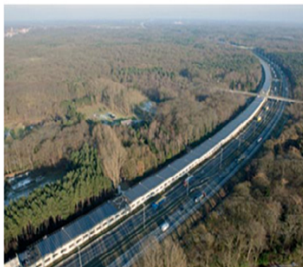
Figura 2.16 - Túnel solar (Fonte: Ecologist, 2011)
