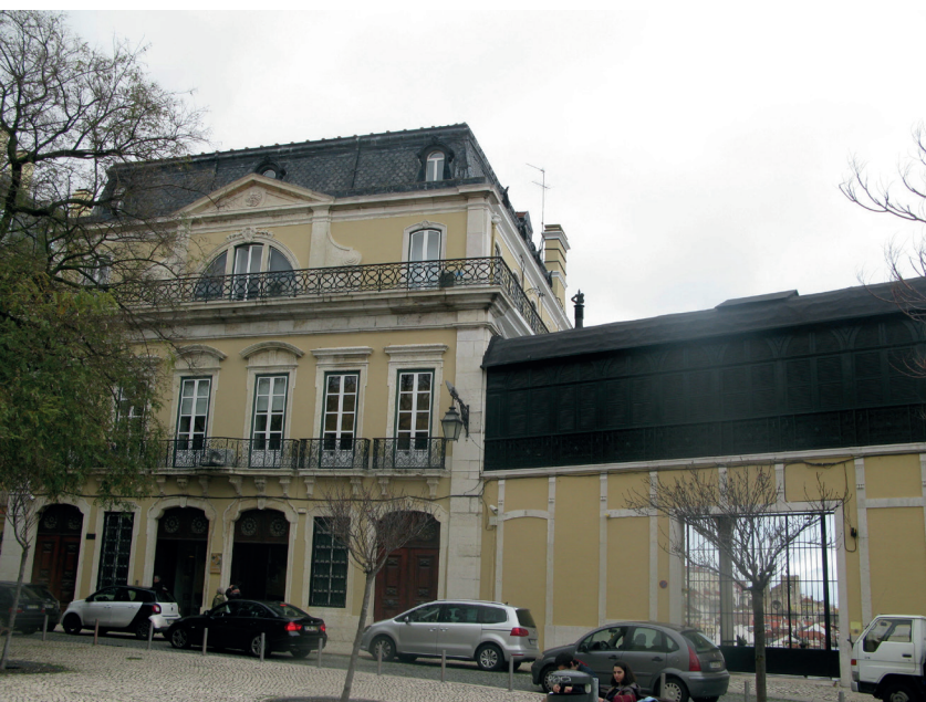
Fig.1 – Edifício do Largo da Biblioteca Pública, propriedade de José Bento de Araújo, e casa de família dos seus sobrinhos (Fotografia das autoras)
