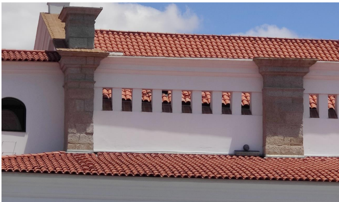
Fig. 98: Pilastras com capitéis abreviados na face lateral da Igreja do Espírito Santo (fotografia do autor)
