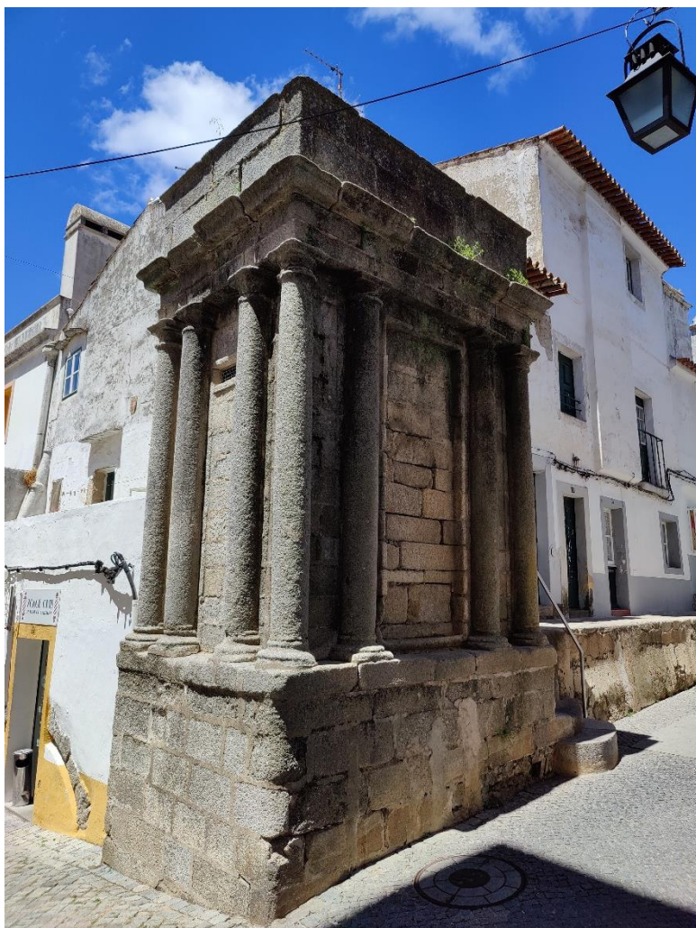
Fig. 74: Caixa de Água da Rua Nova, 1536, Évora (fotografia do autor)
