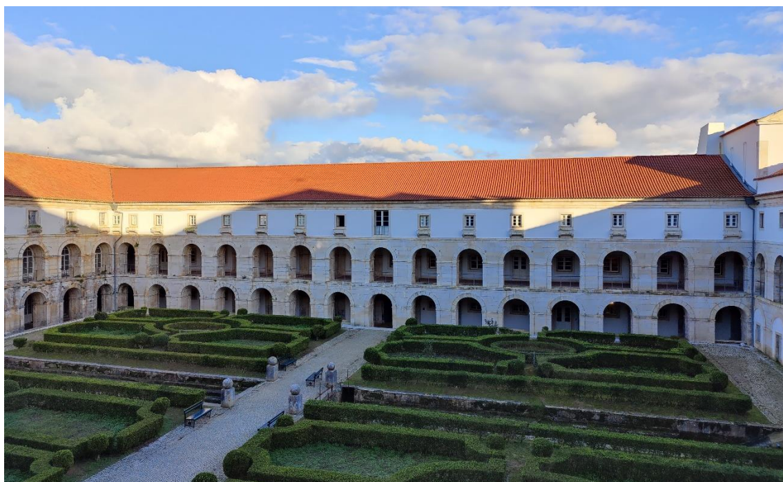
Fig. 2: Claustro dos Noviços, ou “Claustro do Cardeal”, c. 1550-60, Mosteiro de Alcobaça (fotografia do autor)
