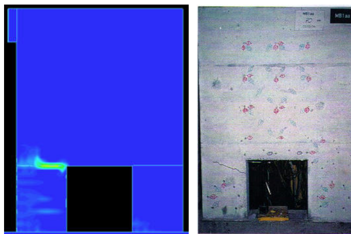
Figura 5.9 – Fendilhação a 70 kN (Ponto A na Figura 5.5)
